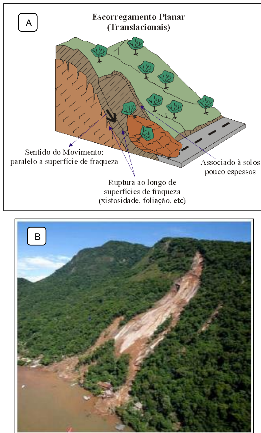
Figura 3.1: A) Esquema de um escorregamento planar. B) Escorregamento planar ocorrido na praia do Bananal, Ilha Grande em 2010.
