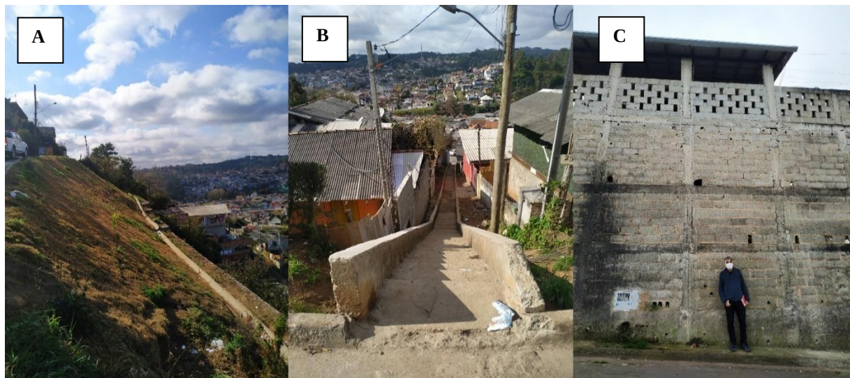
Figura 16. Obras estruturais observadas em campo. a) Canaleta de drenagem. b) Escada hidráulica. c) Muro de contenção com canaletas de drenagem, que auxiliam no escoamento das águas infiltradas no terreno
