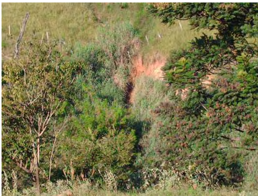
Figura 14. Presença de pequenos processos erosivos na Unidade IV, em área de APP do Córrego Bertini.
