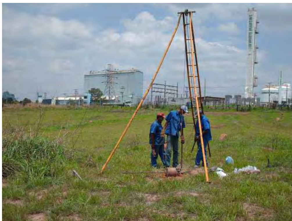
Figura 7. Execução da sondagem a percussão (SP-15) próxima à empresa White Martins.
