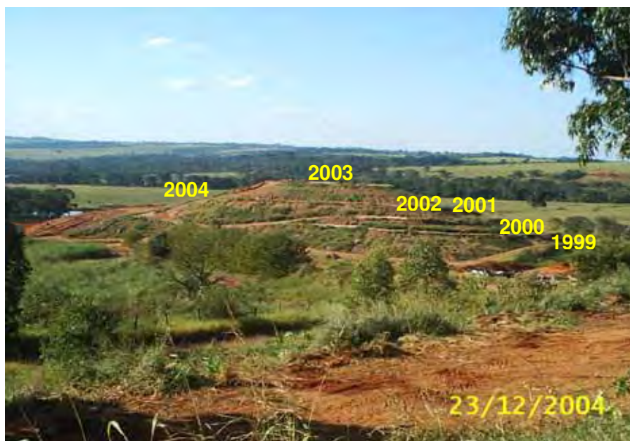
Figura 7: Vista do aterro indicando as células, onde foram realizadas as perfurações e retiradas de amostras
