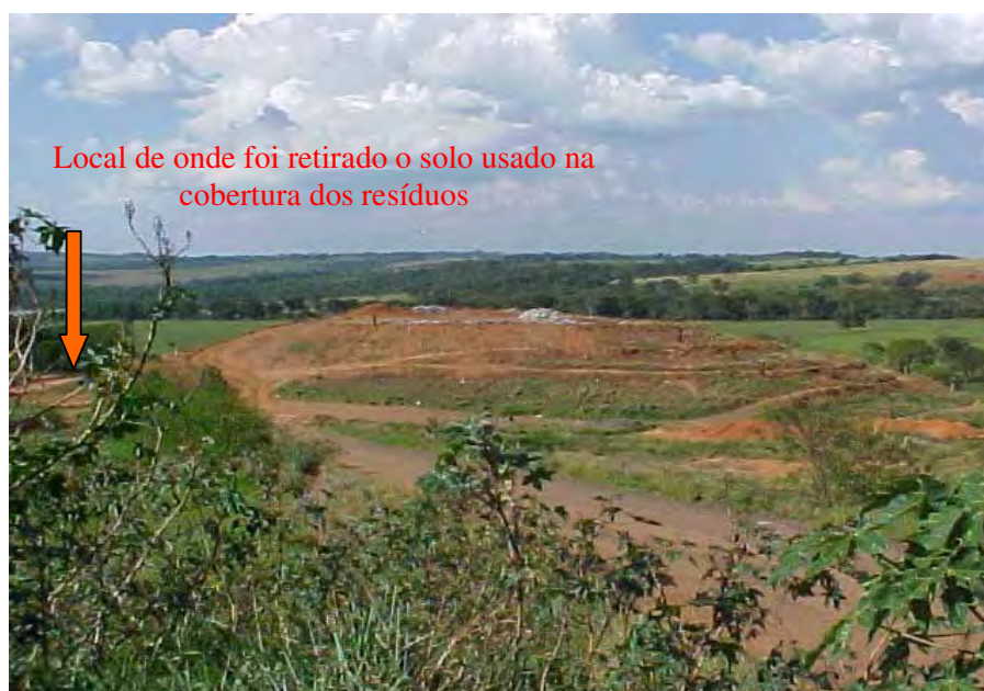
Figura 6: Panorama do aterro sanitário de São Carlos, 2004
