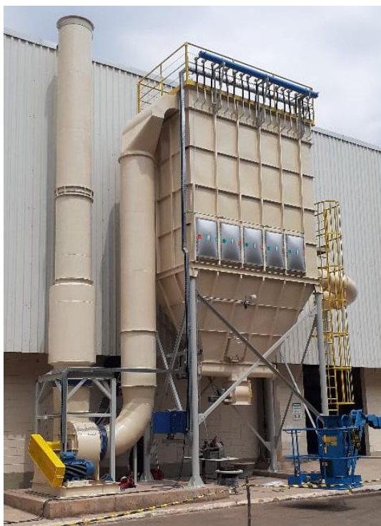
Figura 4.3 – Foto de um filtro de mangas com ventilador centrífugo
