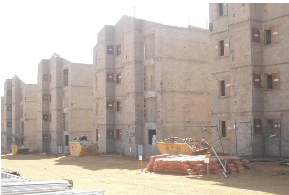
FOTO 20 – Estágio de obras em março de 2015
