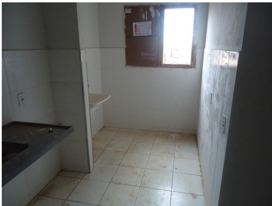
FOTO 15 – Parte Interna: lavanderia do apartamento (em construção)
