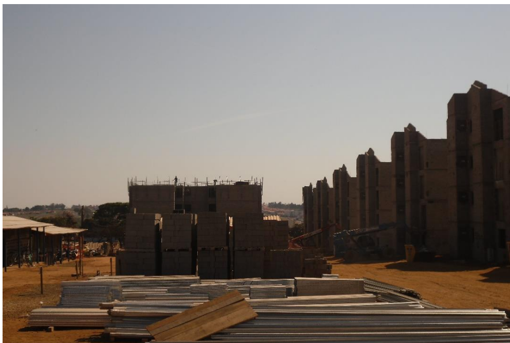
FOTO 19 – Estágio de obras em março de 2015.
