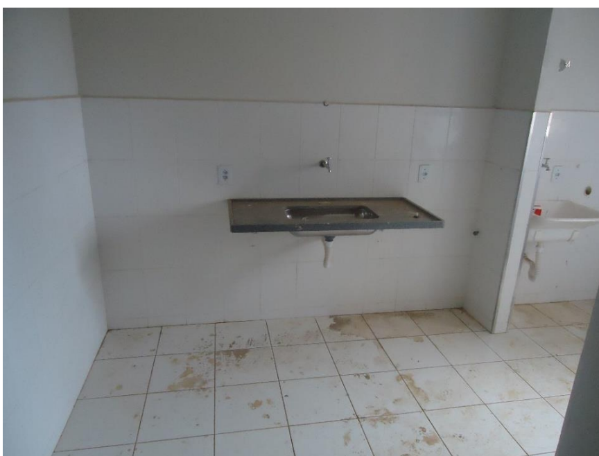
FOTO 13 – Parte Interna: cozinha do apartamento (em construção)
