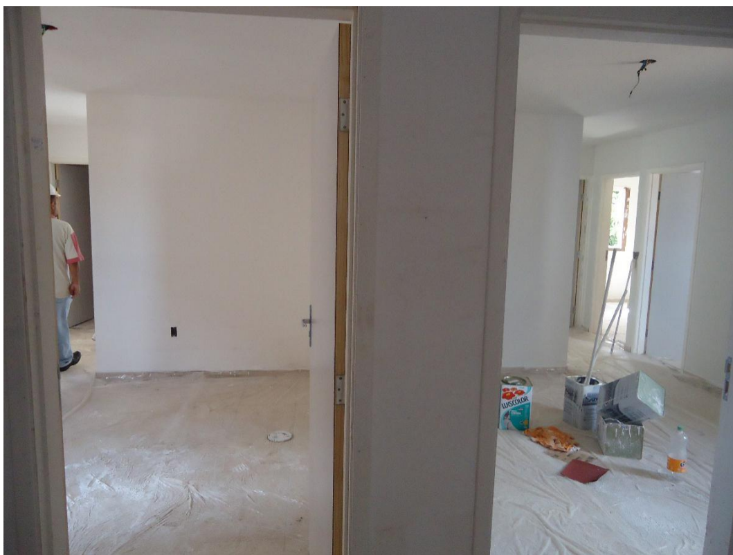
FOTO 11 – Visão do hall que acessa apartamentos do Residencial Rubi I
