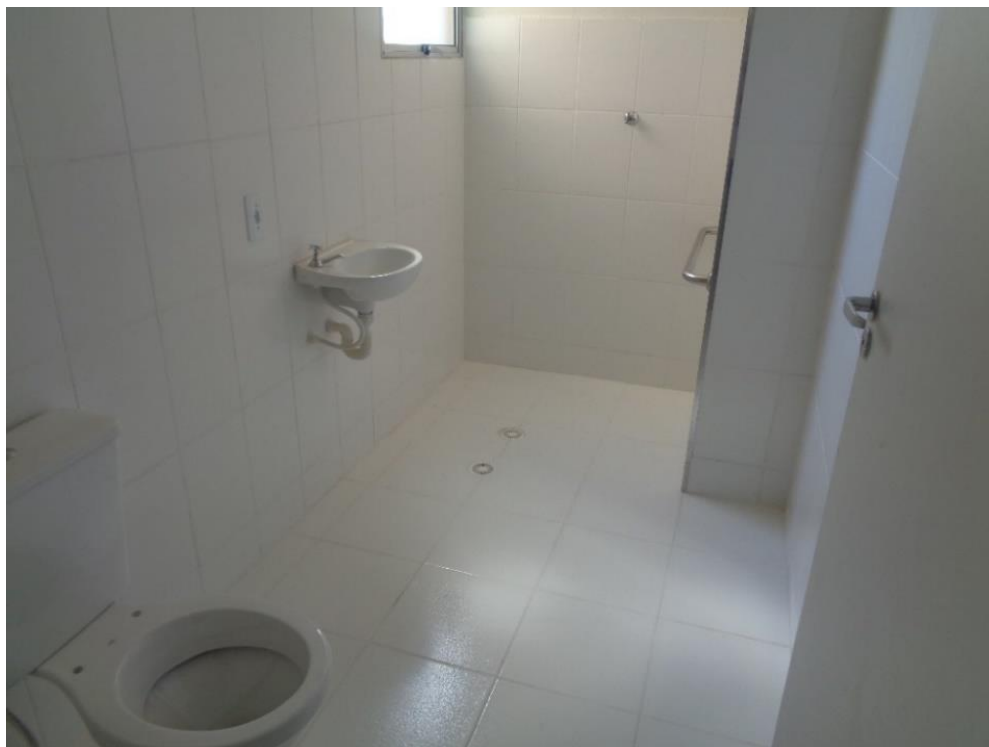
FOTO 14 – Parte Interna: banheiro do apartamento
