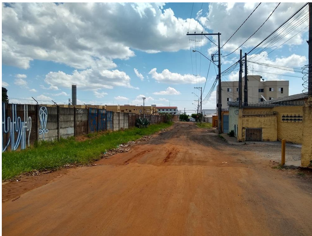
FOTO 29 – Trecho da Rua Paulo Archetti sem pavimentação
