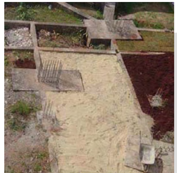
Terreno apos a colocação da grama e areia
