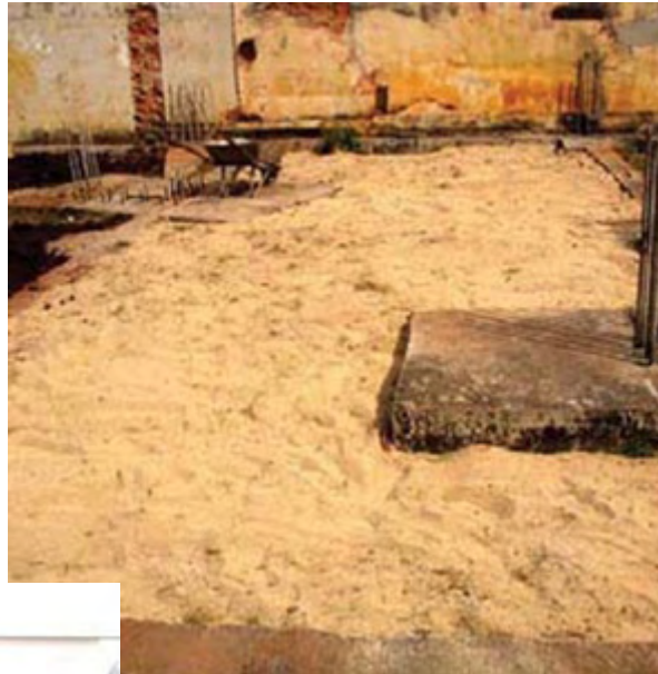
Colocação de areia
