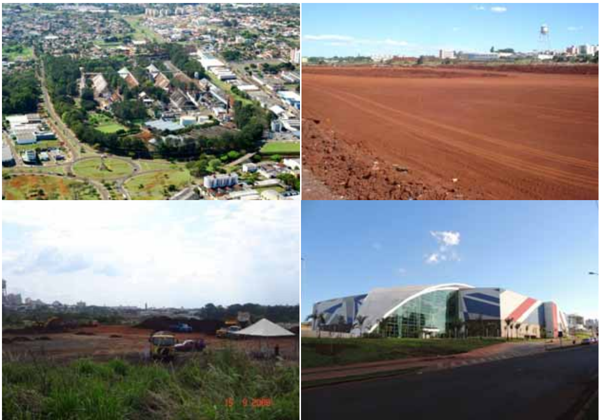
Figura 17 - Londrina. Imagem da antiga refinaria Anderson Clayton, terraplanagem do terreno em 2008, o Boulevard Londrina Shopping em 2013, o Hotel Ibis em 2013 e a loja da Leroy Merlin em 2014.
