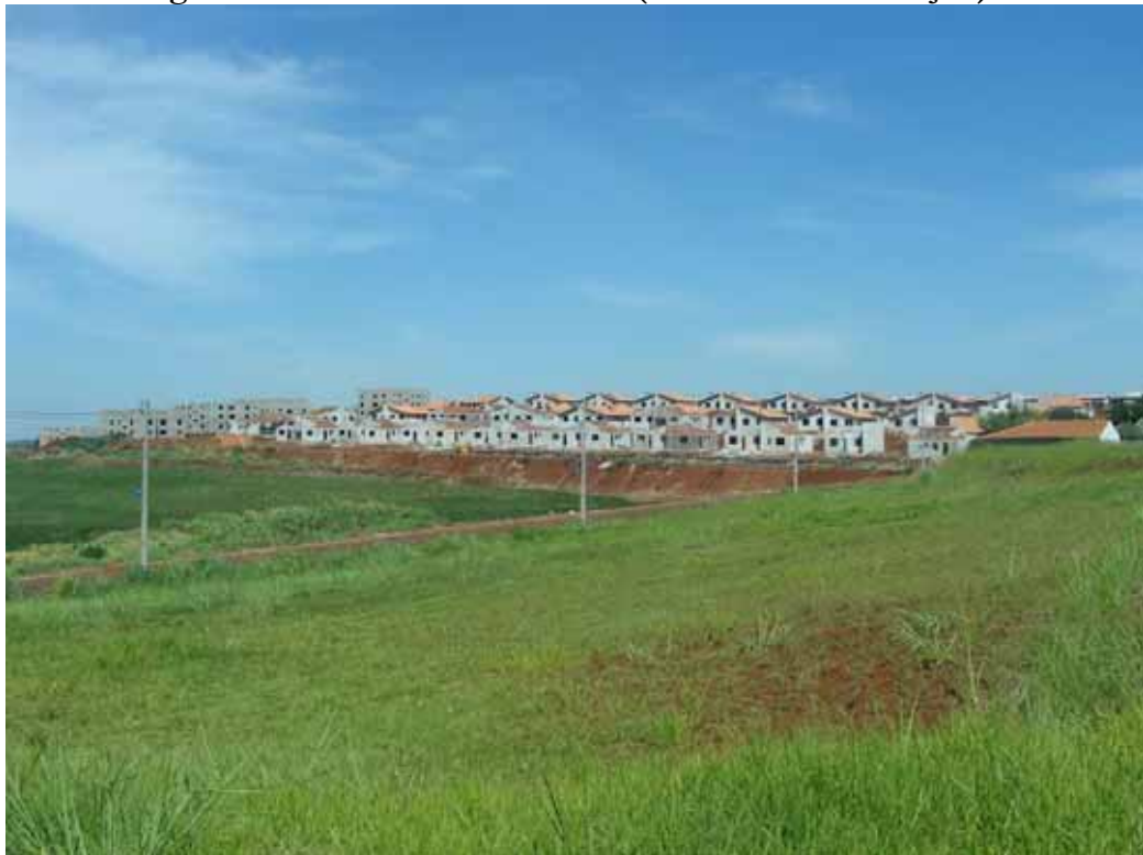
Figura 23 - Maringá. Residencial Dolores Duran (em fase de construção). 2011.
