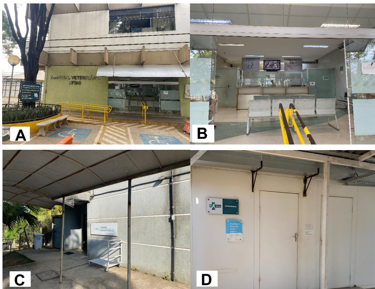
Figura 1. Estrutura do Hospital da Escola de Veterinária da UFMG. A. Fachada do hospital veterinário. B. Recepção e sala de espera. C. Entrada da Internação da clínica médica de animais de companhia. D. Entrada da Unidade de Terapia Intensiva (UTI). Fonte: Arquivo Pessoal.
