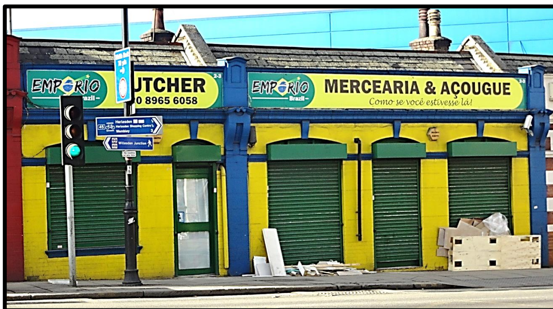
Fotografia 27 - Reforma do Empório Brazil – Merceria e açougue na Station Road – Willesden Junction - Brent
