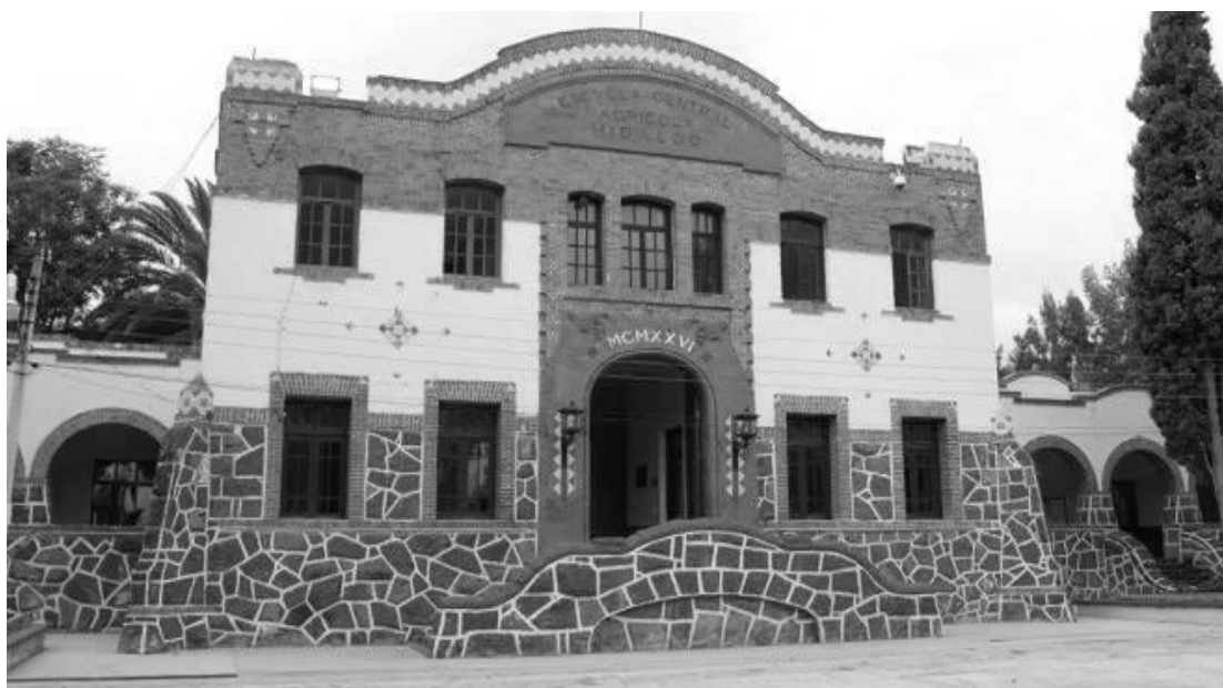
Figura 94 – Fachada da Escola Normal Rural de El Mexe
