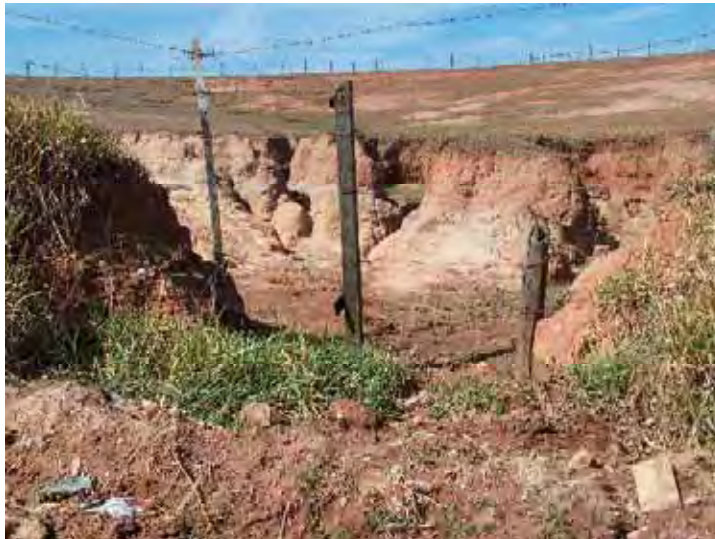
Foto 3 – Presença de ravinamento no setor leste. Fonte: Borges, 2006.
