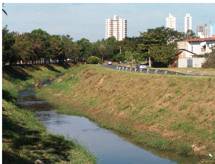
Foto 5 – O entalhamento do vale demonstra a retomada erosiva da drenagem sobre seus depósitos antigos.
