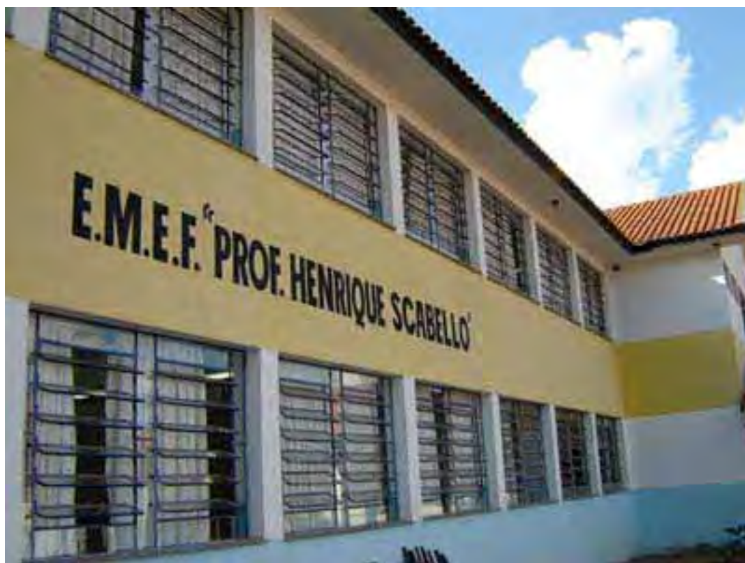
Foto 03. Fachada da Escola Municipal de Ensino Fundamental Henrique Scabello
