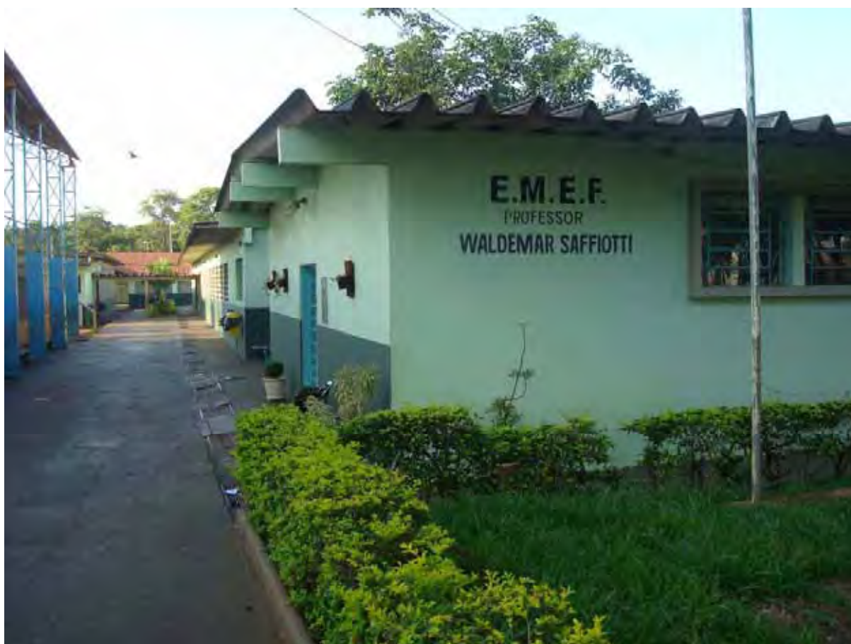
Foto 10. Fachada da Escola Municipal de Ensino Fundamental Waldemar Saffiotti
