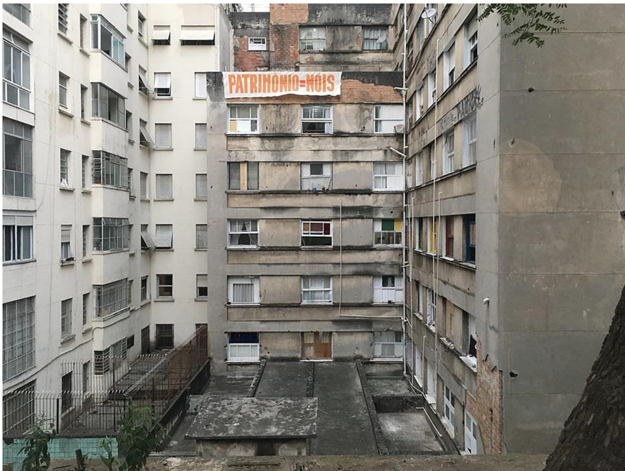
Figura 26 - Intervenção artística na Ocupação 9 de Julho, por Erica Ferrari
