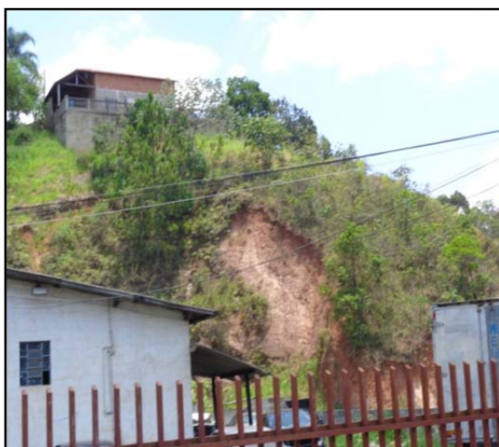
FOTO 3. Vista geral de cicatriz de escorregamento em talude de corte próximo a moradia.
