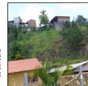
Vista na qual há diversas moradias, instaladas na base e no topo da encosta, próximos a taludes de corte
