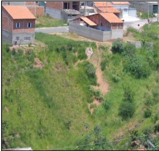
FOTO 9. Vista geral de cicatriz de escorregamento em talude de corte próximo a moradia.
