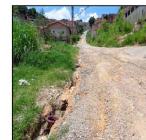
Vista geral processo erosivo avançado ocasionado pela ausência de estrutura de contenção
