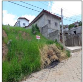
Vista geral decorte em talude, sendo comercializado em área de risco
