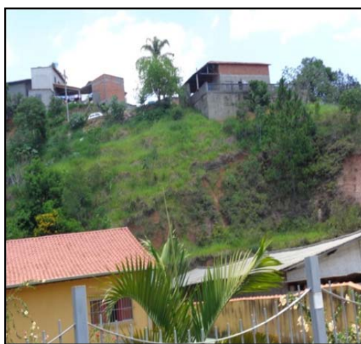
FOTO 2. Vista na qual há um renque de moradias, instaladas na base de encosta, próximo a taludes de corte.
