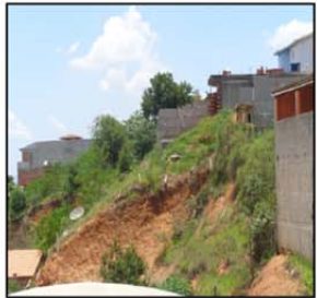
Vista geral de cicatriz de escorregamento em corte de talude próximo a moradia
