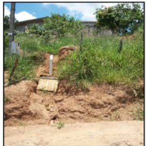
Vista de casa com ausência de captação de esgoto, despejando água servida no solo
