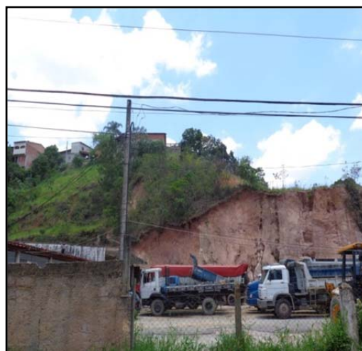
FOTO 4. Vista de corte em talude (notar a altura da encosta e a proximidade das moradias).
