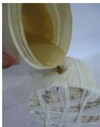
Figura 43 – Preenchimento do molde.
