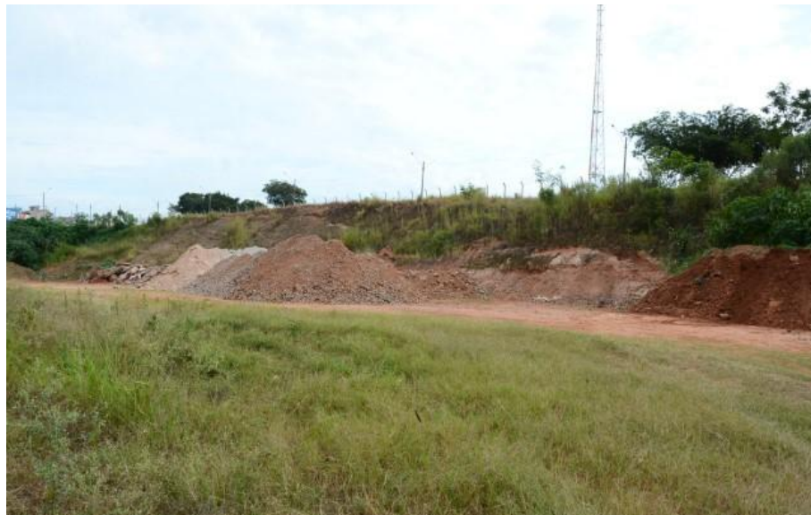
Figura 54: Ecoponto em construção no município de Presidente Prudente
