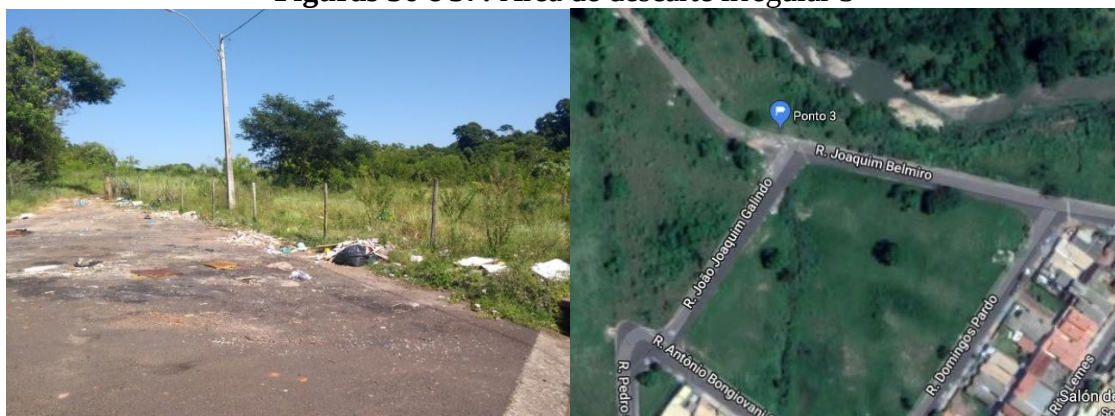
Figuras 36 e 37: Área de descarte irregular 3
