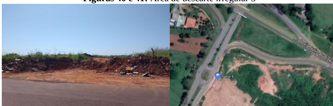
Figuras 40 e 41: Área de descarte irregular 5
