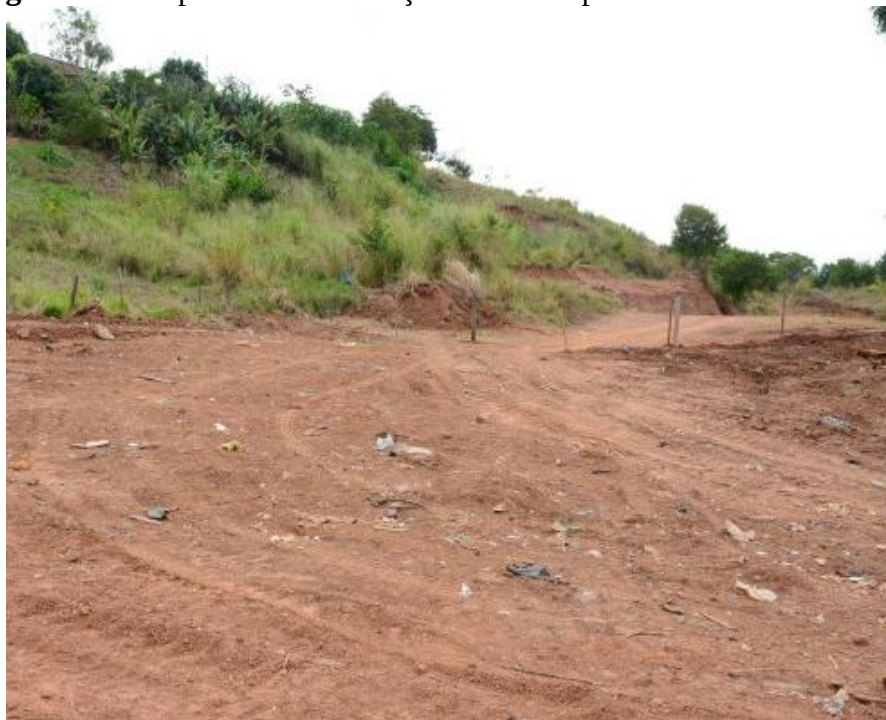
Figura 53: Ecoponto em construção no município de Presidente Prudente
