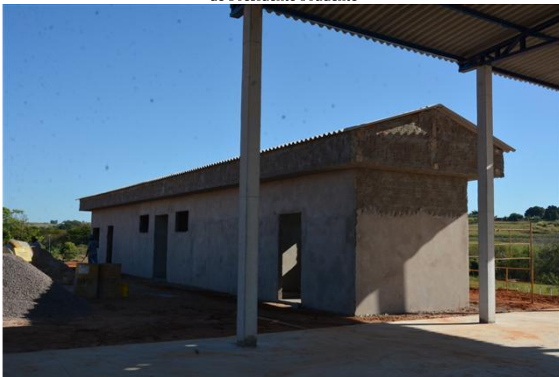
Figura 52: Centro de Triagem de Resíduos da Construção Civil em construção no município de Presidente Prudente
