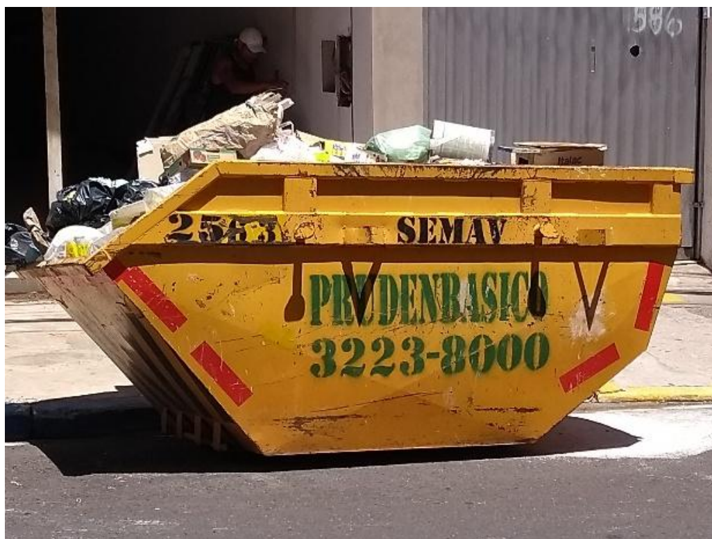
Figura 48: Caçamba com mistura incorreta de materiais em Presidente Prudente
