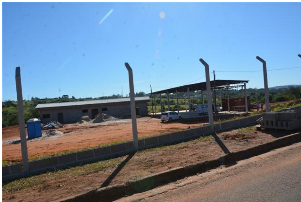
Figura 51: Centro de Triagem de Resíduos da Construção Civil em construção no município de Presidente Prudente
