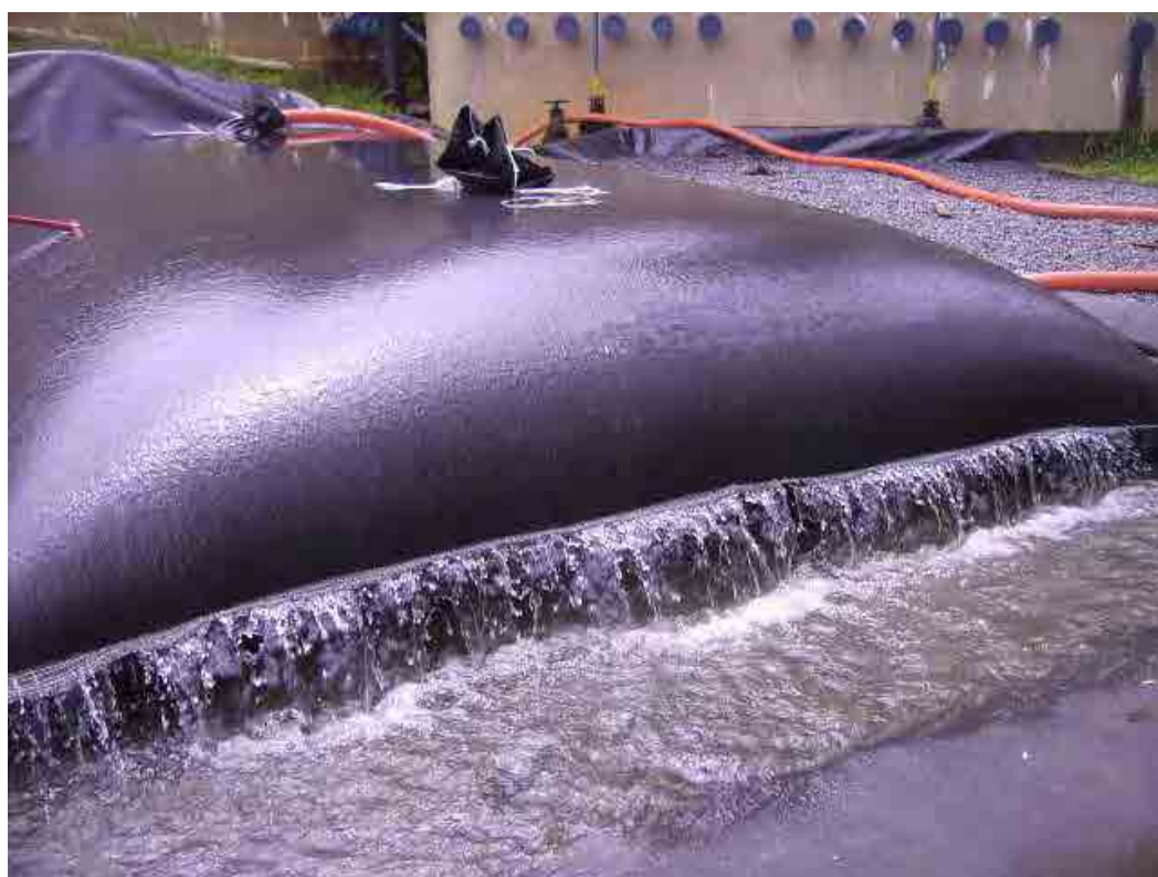
Figura 4.10 – Preenchimento da geofôrma (Arquivo particular Huesker, 2011)
