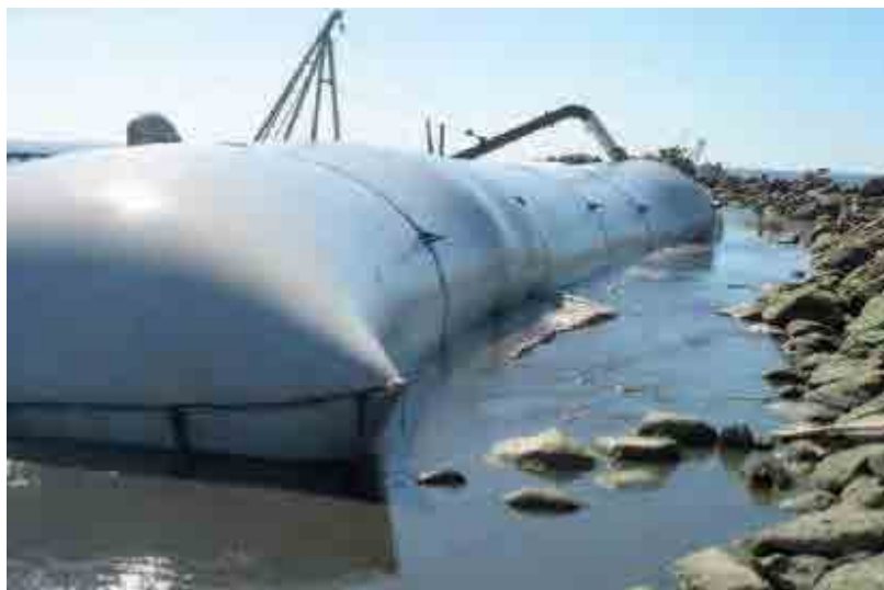
Figura 3.3 – Exemplo de geofôrma linear aplicada em proteção costeira (Huesker, 2011)
