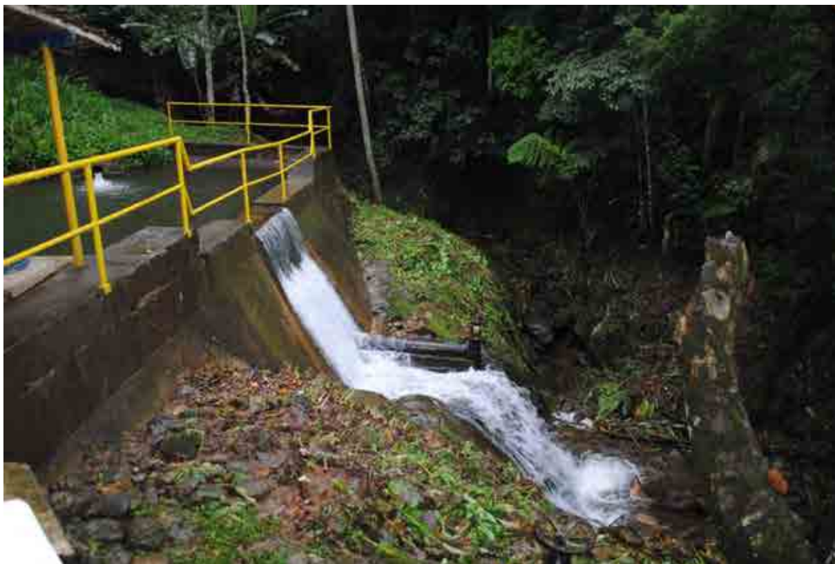
Figura 1.1 – Barragem de nível para captação da ETA Piquete (Arquivo particular Huesker, 2011)
