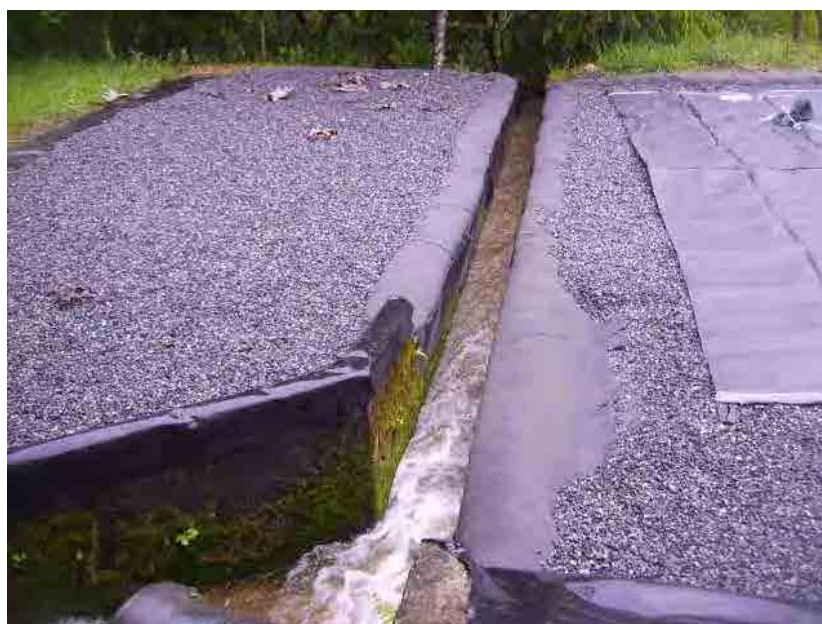
Figura 4.9 - Berço e canal de drenagem (Arquivo particular Huesker, 2011)
