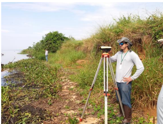
Figura 1. Visão geral - primeira parte do Talude 226.
