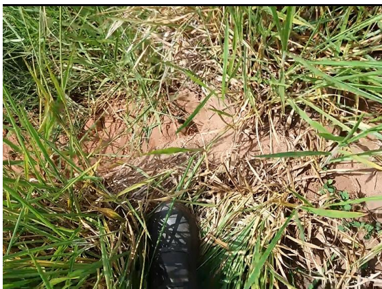
Figura 8. Oitavo ponto – visão do topo do Talude 227.
