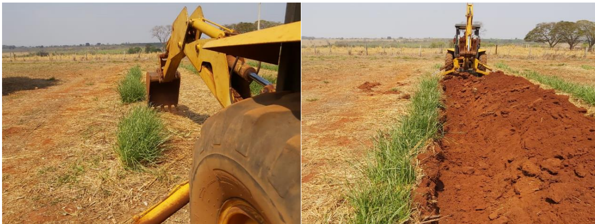
Figura 66 - Execução da valeta para retirada de mudas do capim vetiver.
