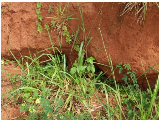
Figura 3. Terceiro ponto – Talude 227.
