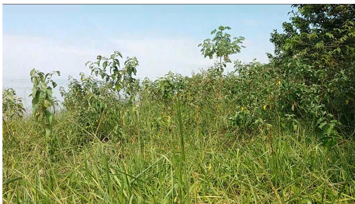
Figura 7. Vegetação na parte superior do Talude 226.
