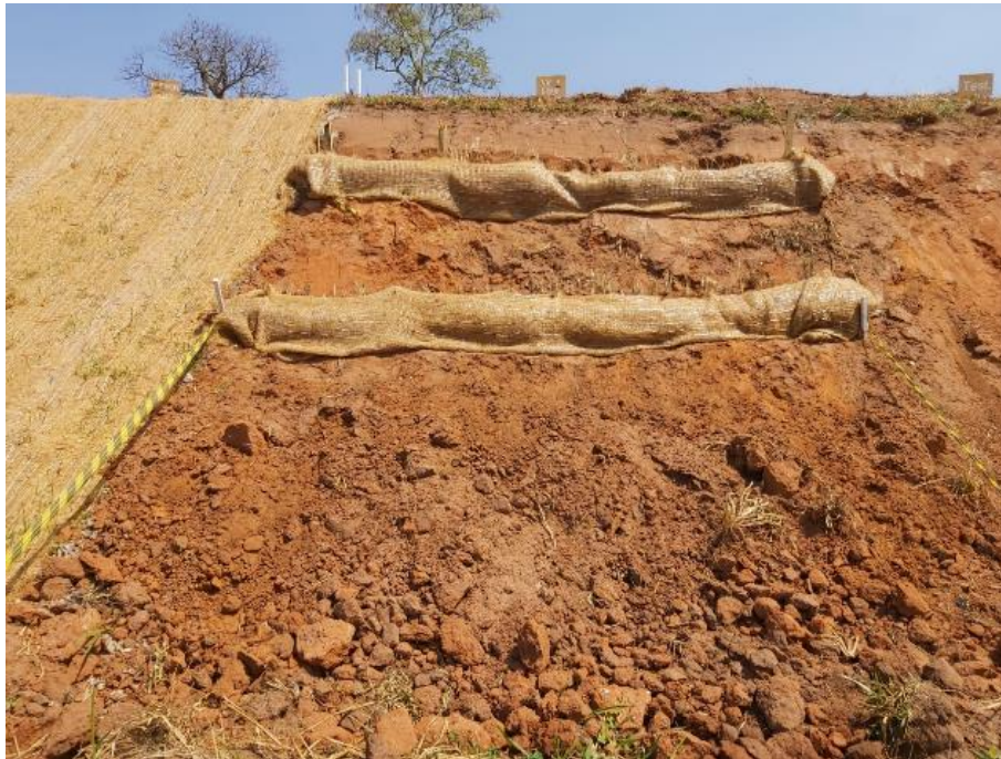
Figura 102 - Barreiras de Capim Vetiver e Biorretentores instalados.
