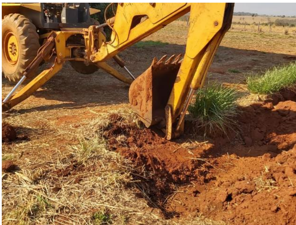
Figura 67 - Retirada das touceiras de capim vetiver.
