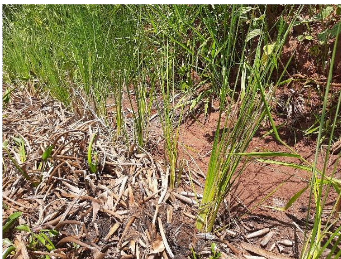
Figura 166 - Linha do capim vetiver no pé do Talude 227.
