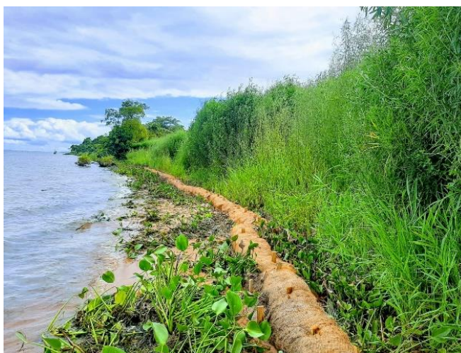
Figura 170 - Fotografia do Talude 227 de 27 fevereiro de 2020.
