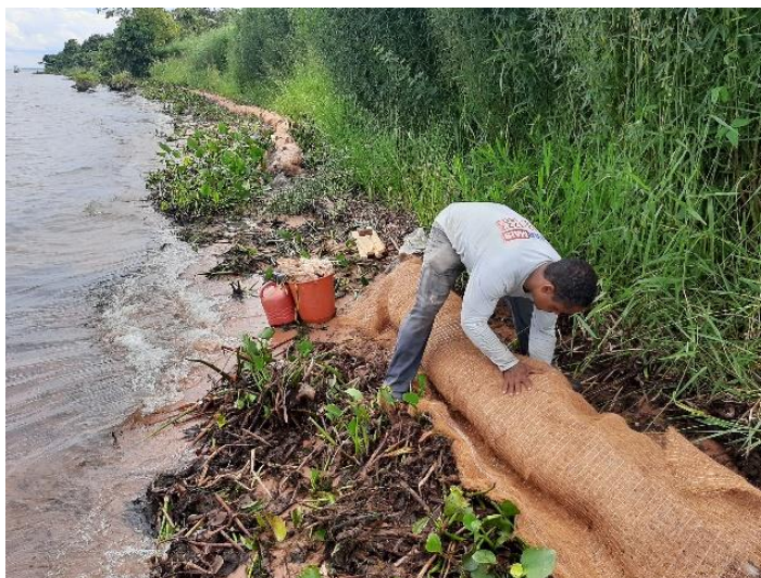
Figura 81 - Biorretentor sendo encapado com biomanta de fibra de coco.
