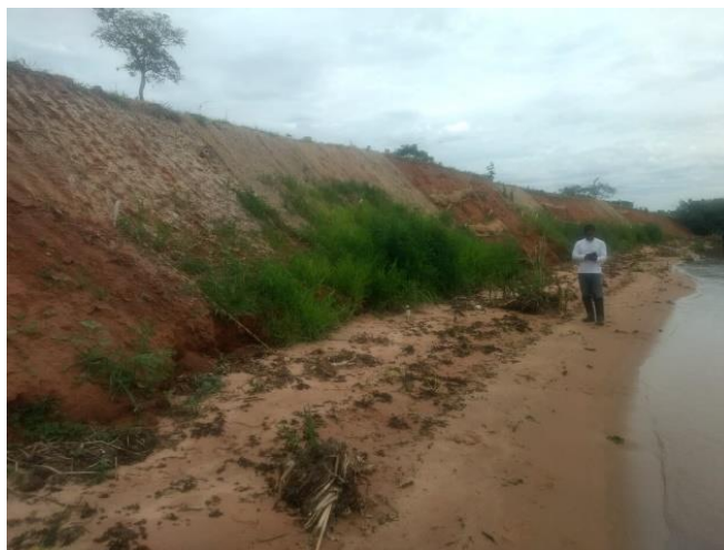
Figura 109 - Foto do Talude 227 tirada no dia 27/11/2019 com sentido de jusante a montante.
