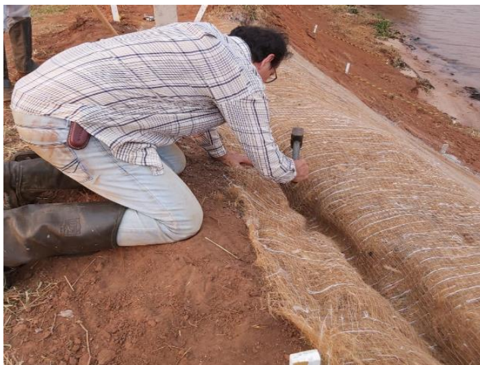
Figura 63 - Grampeamento da biomanta no fundo da vala de ancoragem.
