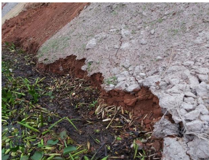
Figura 106 - Solapamento em parcela de mix.
