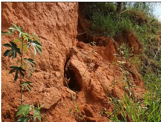
Figura 6. Quinto ponto – Talude 227.
