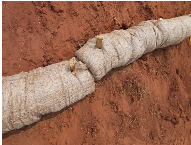
Figura 71 - Fixação do biorretentor com estacas de madeira.
