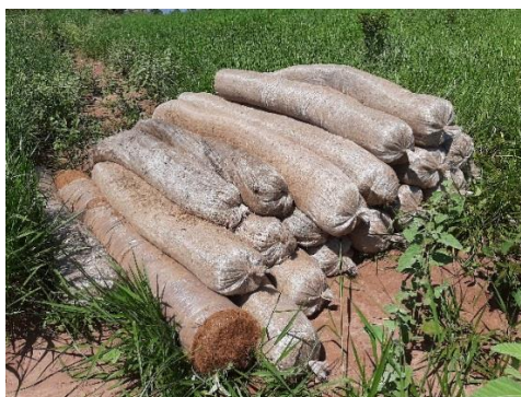
Figura 80 - Pilha de biorretentores e biomanta de fibra de coco armazenadas na crista do talude.
