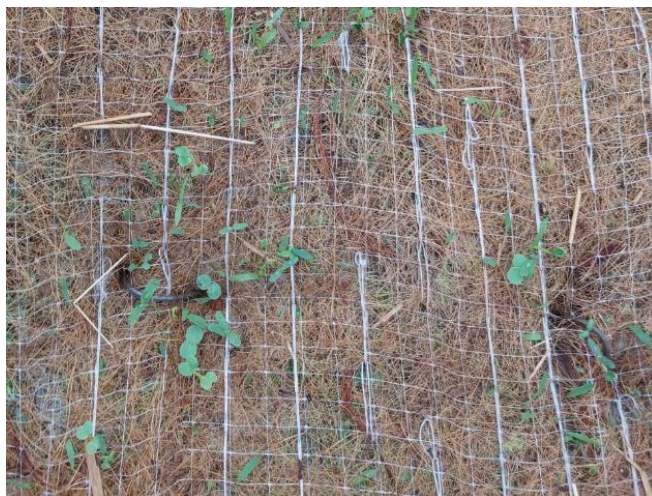
Figura 105 - Plântulas em uma parcela com mix de sementes e biomanta de fibra de coco.
