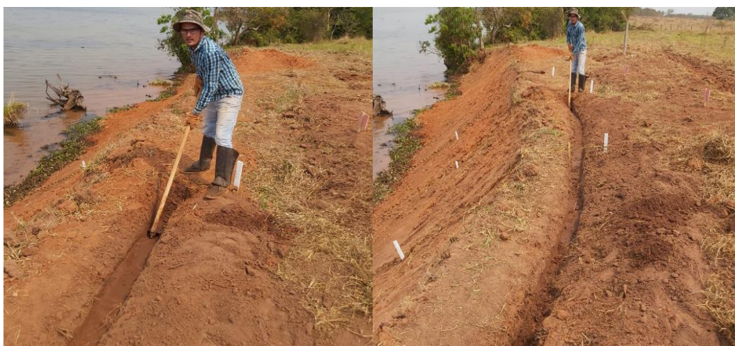
Figura 61 - Escavação da vala de ancoragem das biomanta.
