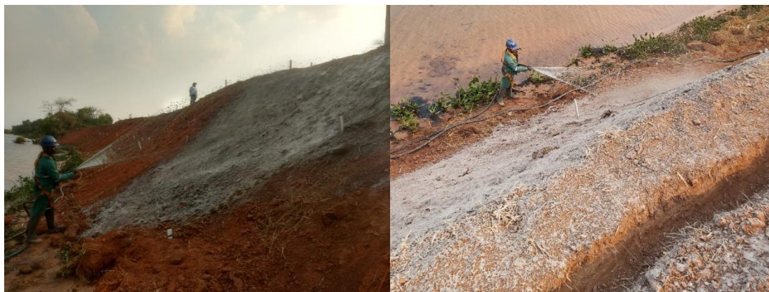
Figura 56 - Execução da hidrossemeadura.
