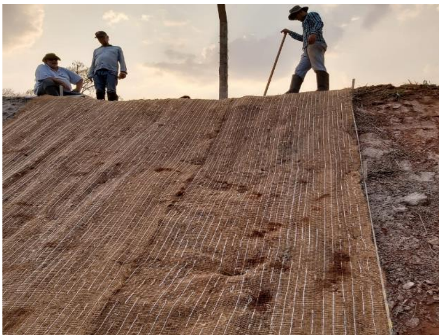
Figura 100 - Biomanta Fibrax 300 RD instalada.
