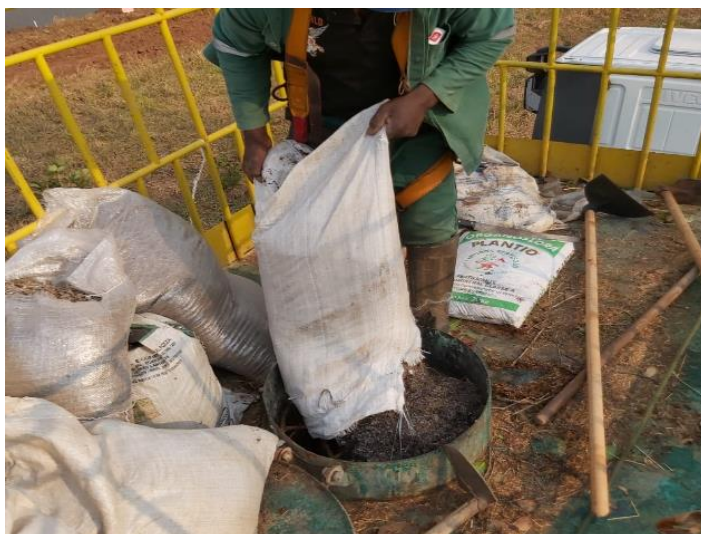
Figura 55 - Despejo do mega mulch no tanque.
