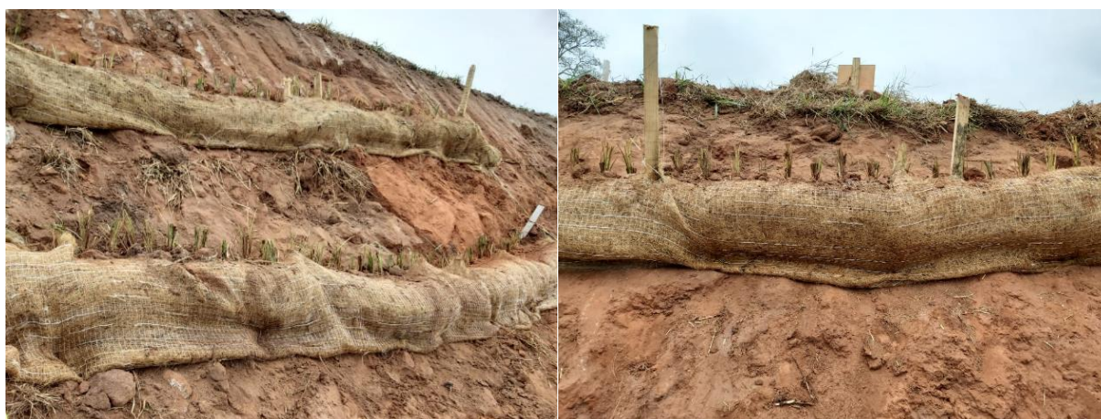
Figura 74 - Biorretentores e barreiras de capim vetiver instalados.
