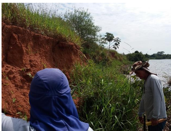
Figura 1. Visão geral do talude.
