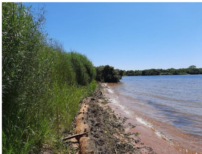
Figura 169 - Fotografia do Talude 227 de 06 de fevereiro de 2020.
