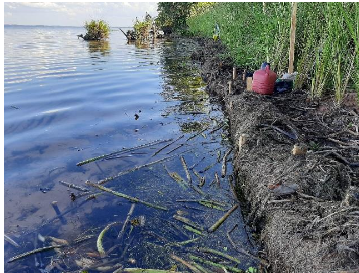
Figura 167 - Nível da água atingindo os biorretentores no dia 05/03/2020.
