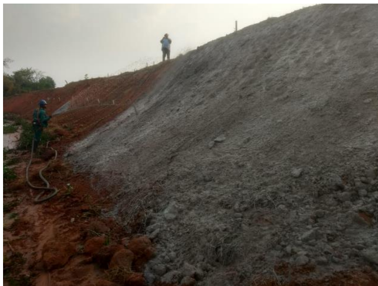
Figura 41 - Execução da hidrossemeadura.
