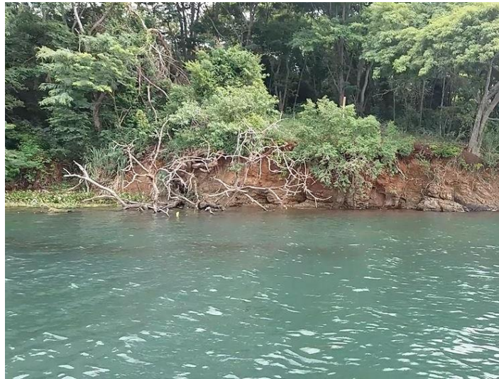
Figura 86 - Talude 223 – município de Selvíria (MS).
