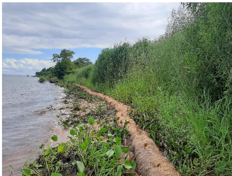
Figura 83 - Fileira de biorrtentor instalada.
