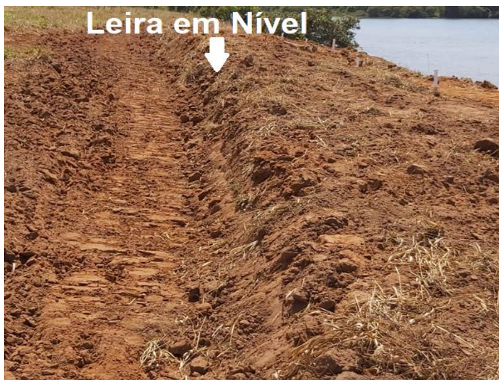
Figura 37 - Leira em Nível acima da crista do talude 227.
