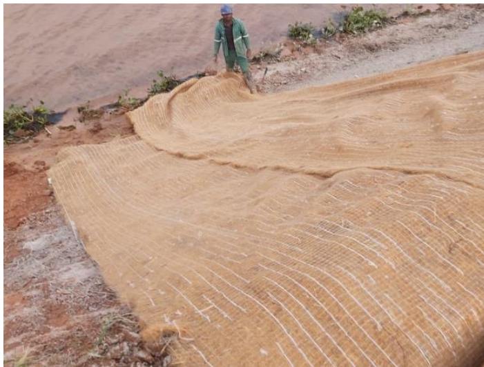
Figura 62 - Biomanta Fibrax 300 RD sendo desenrolada.
