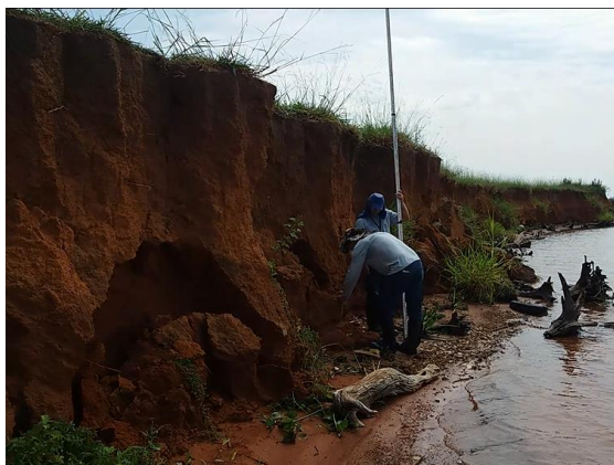
Figura 10. Visão geral de uma parte do Talude 229.
