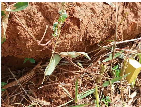
Figura 5. Quinto ponto (visão inferior) - Talude 227.
