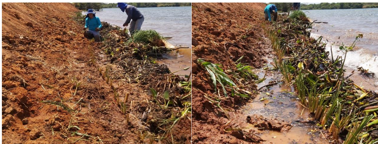
Figura 69 - Plantação da barreira de vetiver no pé do talude.
