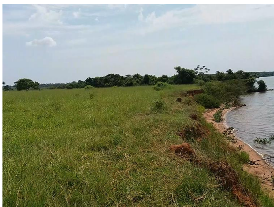
Figura 14. Visão da parte superior – Talude 229.
