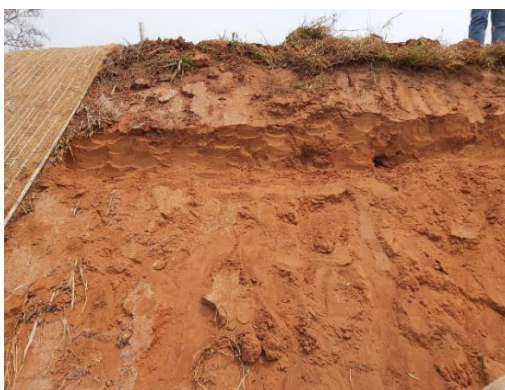
Figura 70 - Valeta para fixação de biorretentor.
