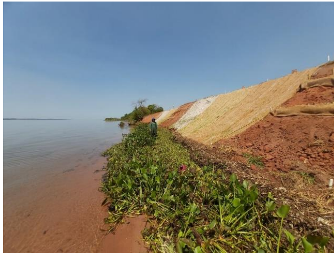
Figura 107 - Foto do Talude 227 tirada no dia 29/09/2019 com sentido de montante à jusante.
