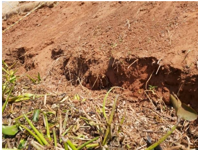
Figura 134 - Solapamento na Parcela 5 (foto tirada no dia 29/09/2019).
