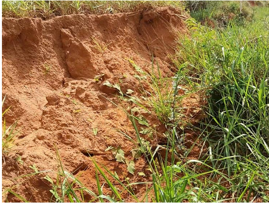
Figura 4. Quarto ponto - Talude 227.
