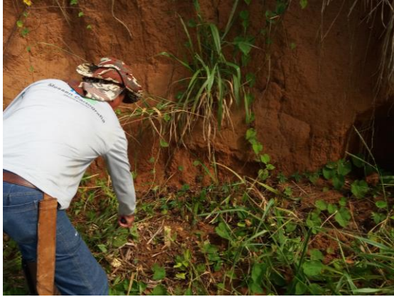
Figura 2. Segundo ponto – primeira parte do Talude 226.
