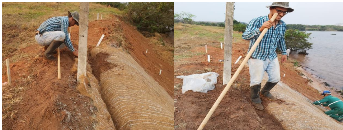
Figura 64 - Execução da ancoragem da biomanta.
