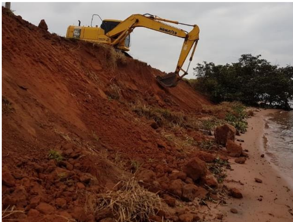
Figura 36 - Escavadeira hidráulica executando o retaludamento do Talude 227.
