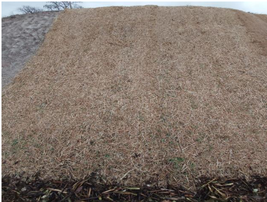
Figura 99 - Biomanta Almax 400 RD instalada.
