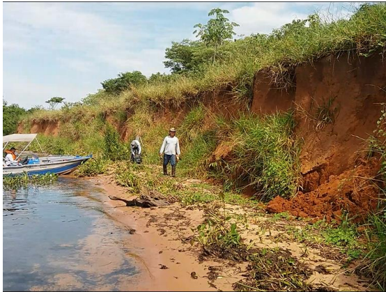
Figura 4. Visão geral - segunda parte do Talude 226.
