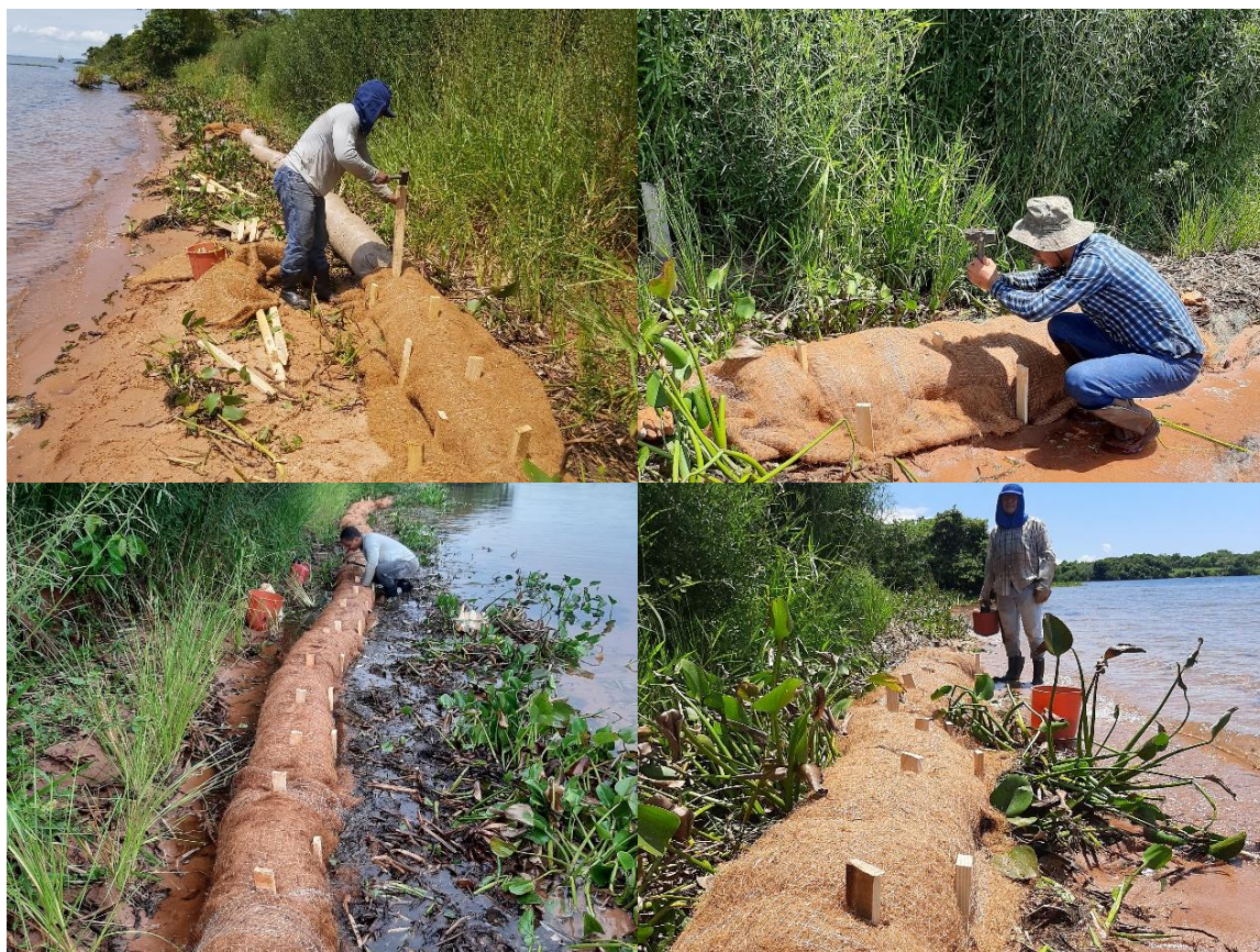
Figura 82 - Instalação dos biorretentores no pé do Talude 227.
