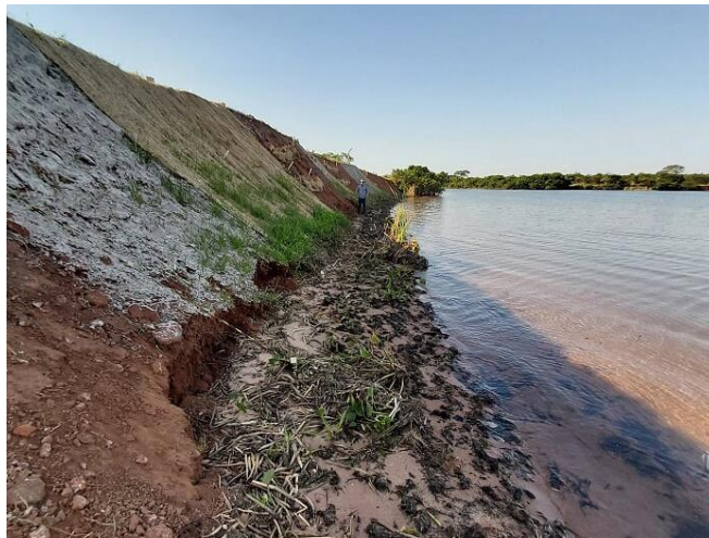
Figura 108 - Foto do Talude 227 tirada no dia 16/10/2019 com sentido de jusante a montante.
