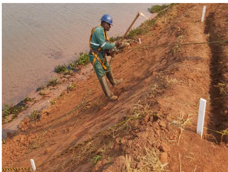
Figura 47 - Coveamento do solo em parcela que recebeu a hidrossemeadura.
