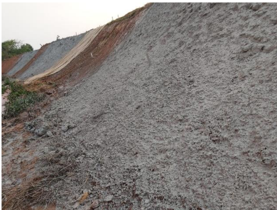
Figura 101 - Hidrossemeadura executada.
