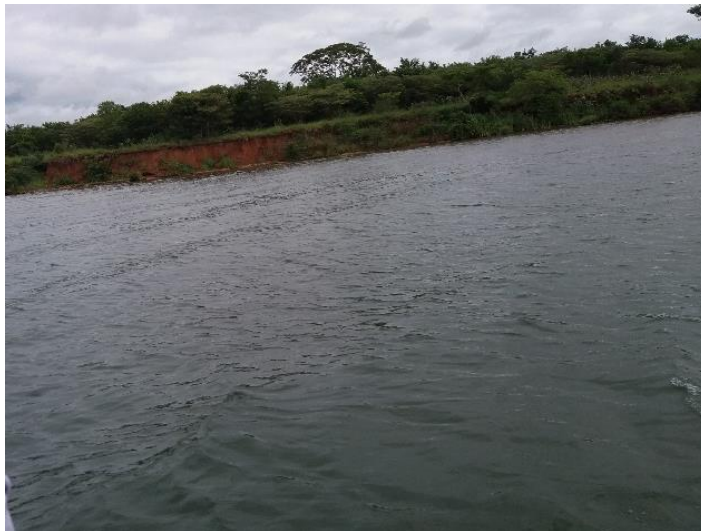
Figura 89 - Talude 226 - município de Três Lagoas (MS).
