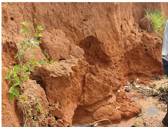
Figura 12. Segundo ponto – segunda parte do Talude 229.
