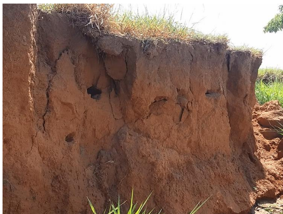
Figura 9. Segundo ponto – primeira parte do Talude 229.
