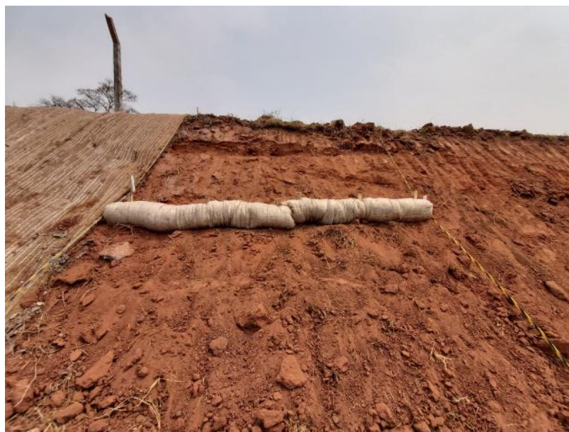
Figura 72 - Biorretentores fixados.
