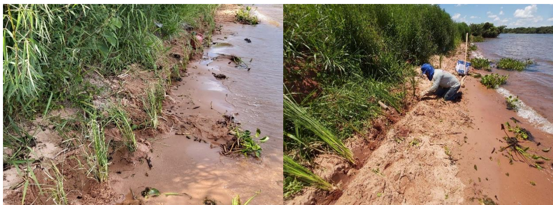
Figura 79 - Replântio da fileira de capim vetiver à frente do pé do talude.
