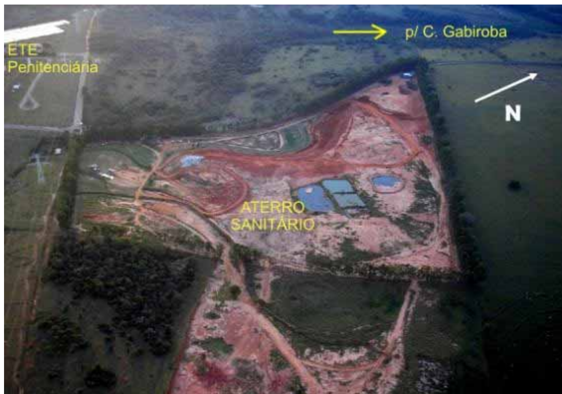
Figura 10 – Vista panorâmica do aterro sanitário de Bauru. Fonte: Adaptado de Mondelli (2008).
