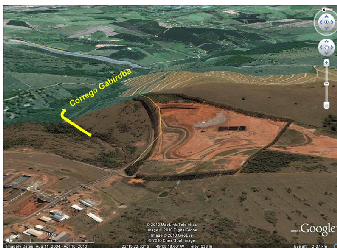
Figura 11 – Vista panorâmica do aterro sanitário de Bauri, evidenciando o fluxo de águas superficiais e o córrego Gabiroba. Imagem de 2004 do Google® (2010).
