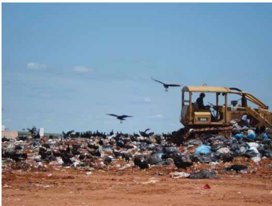
Figura 29 – Compactação dos resíduos sólidos urbanos no aterro sanitário de Bauru.
