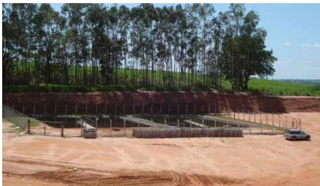
Figura 35 – Lagoas de armazenamento de chorume do aterro sanitário de Bauru, construídas em 2008.
