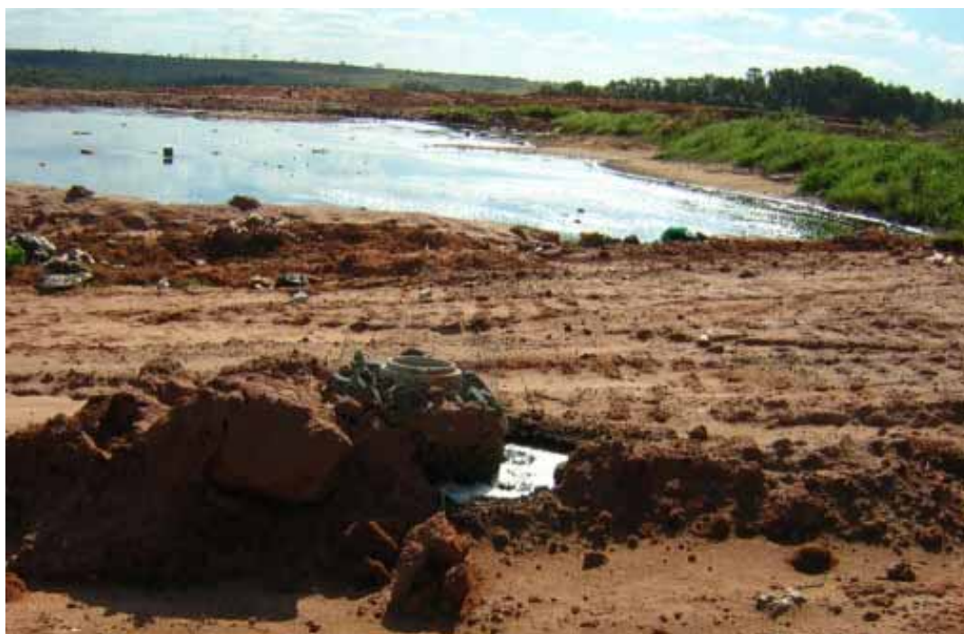
Figura 12 – Lagoa de chorume sobre os resíduos, em segundo plano, e transbordamento de chorume pelo dreno vertical de gás, em primeiro plano. Fonte: Mondelli (2008).
