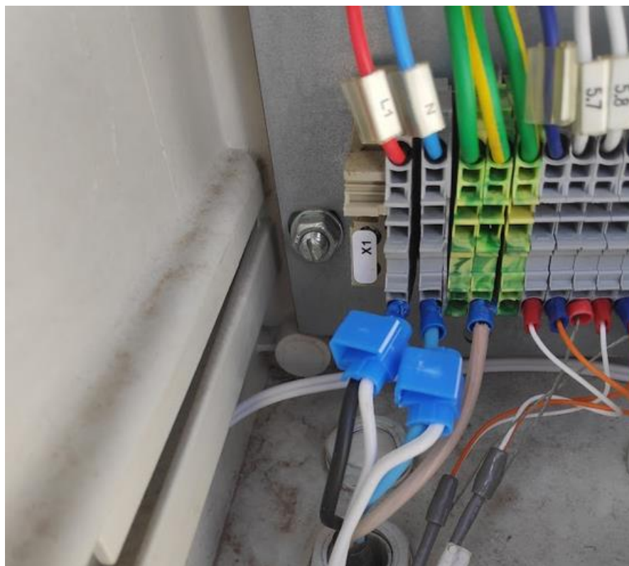
Figura 10 - Alimentação da estação meteorológica com emenda de derivação para alimentação do microcontrolador.
