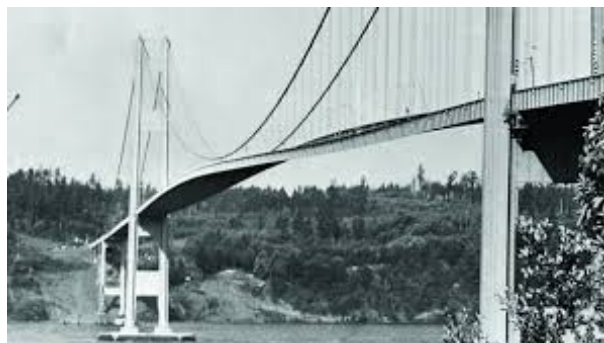
Figura 1 – Ponte Tacoma Narrows: foto tirada antes do desastre
