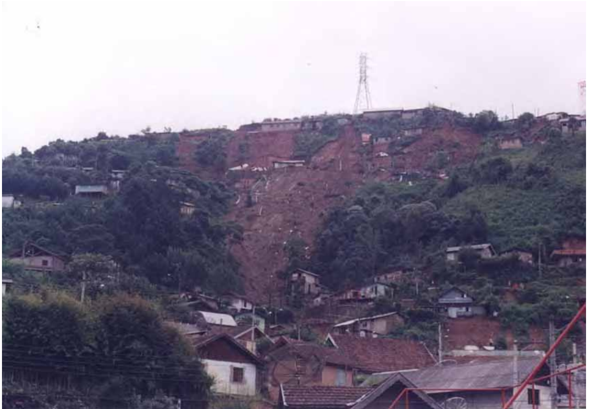
FIGURA 17: Escorregamento ocorrido no Britador em janeiro de 2000. Fonte: Sidnei Silva, 2000
