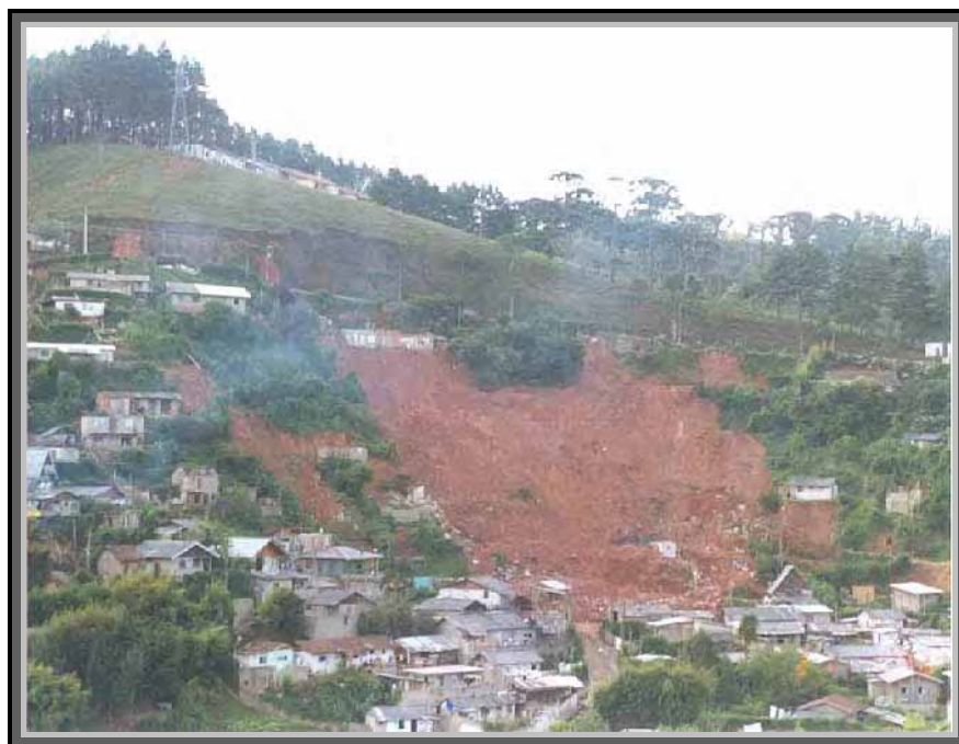
FIGURA 25. Acidente associado a escorregamento translacional em encosta de alta declividade natural situada em porção de cabeceira de drenagem na Vila Santo Antônio.
