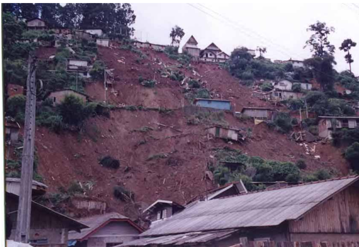
FIGURA 12: Escorregamento ocorrido no Britador em janeiro de 2000. Fonte: Sidnei Silva, 2000
