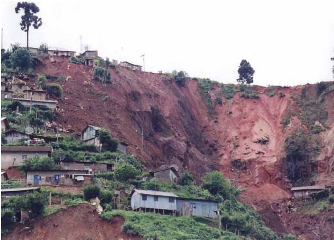
FIGURA 24 - Morro Britador. Vista parcial.
