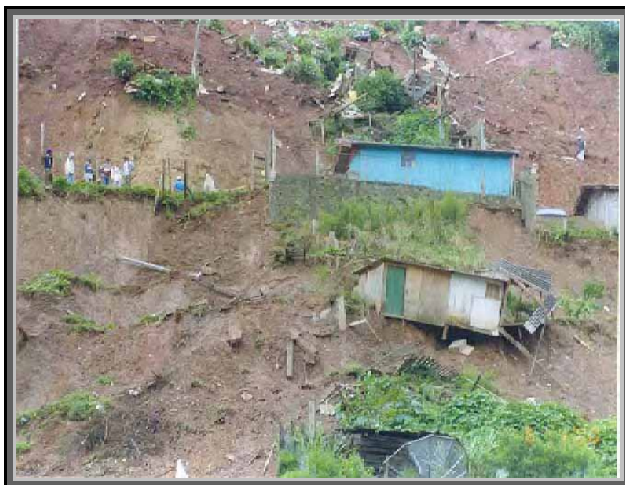
Figura 19 – Detalhe da destruição causada pelos escorregamentos que atingiram as moradias instaladas em patamares de corte e aterro no bairro do Britador. Fonte: Relatório IPT 2003
