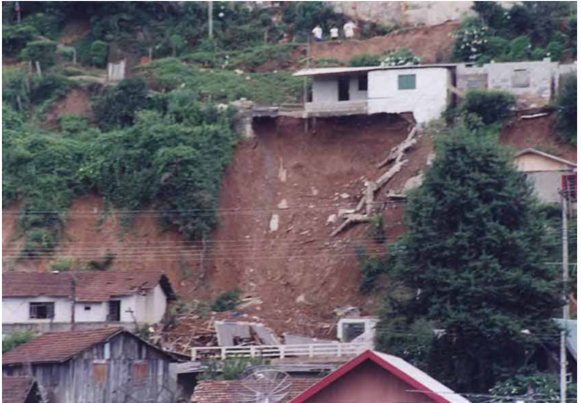
FIGURA 13: Escorregamento ocorrido na V. S. Antônio em janeiro de 2000.
