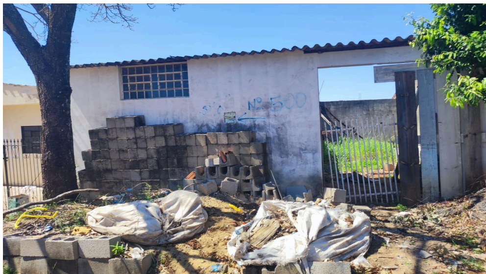
Figura 9: Jardim Morada do Sol. Calçada com entulhos, dificultando a passagem. 2024
