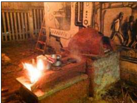
Foto 8 : Fogão de barro construído em oficina de bioconstrução. Fonte: Gabriela Bortolozzo, 2014.
