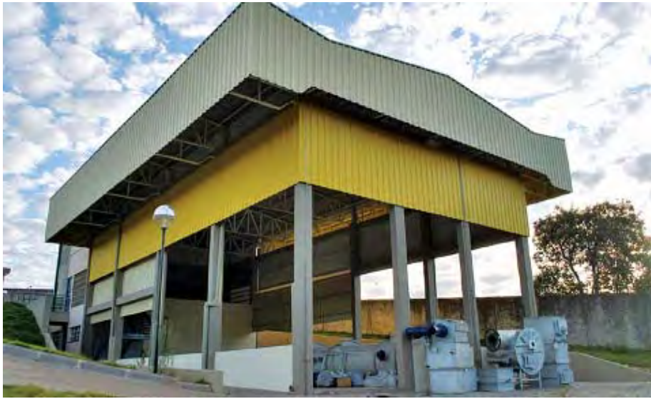
Figura 17: Incinerador para tratamento dos RSS gerados no HC – FMB UNESP de Botucatu, em fase final de instalação.
