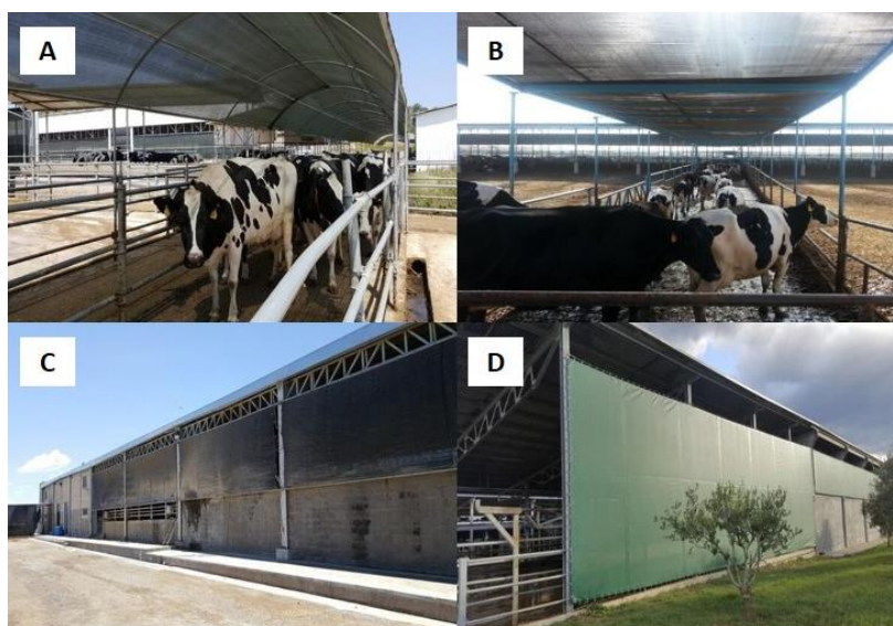
Figura 7. Caminho à sala de ordenha com sombreamento prolongado A= Vacas caminhando até a sala de ordenha; B= Vacas retornando da sala de ordenha; C= Meios de sombreamento simples nas laterais do galpão e D= Corredores de alimentação com sombreamento. Fonte: Romanhuk (2020).
