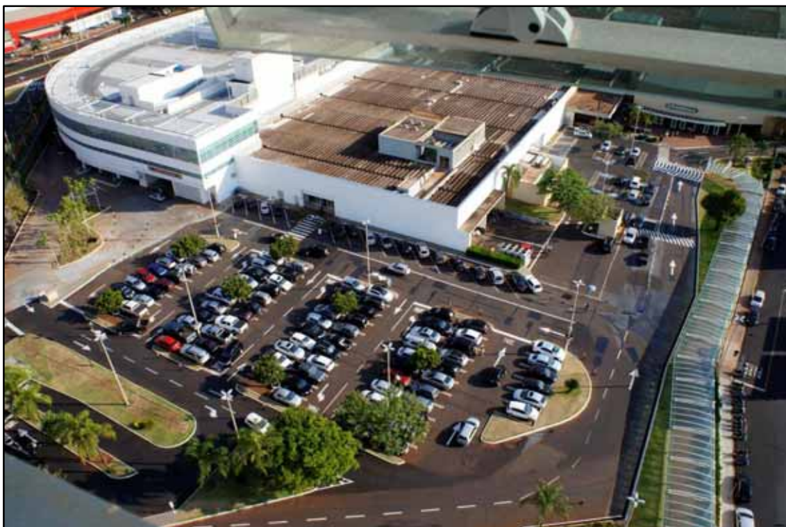
Figura 37: Ribeirão Preto. Ribeirão. (Gasperr, 2014)
