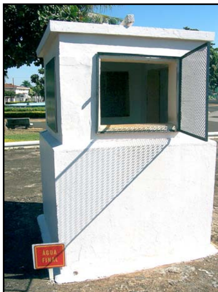
Figura 14. Reservatório 2 (água potável)
