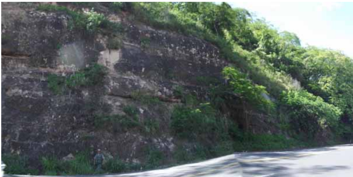
Foto 13. Arenitos carbonatados da Formação Marília, com destaque para o padrão de bancos com espessuras decimétricas a métricas. As porções mais claras apresentam-se mais ricas em nódulos e cimento carbonáticos. Coordenadas do ponto: J45. 50°01'00"W x 22°17'43"S.
