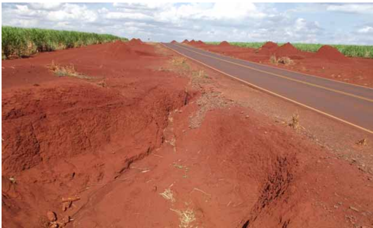
Foto 40. Obras para contenção de enxurrada em área ocupada pelo plantio de cana. Ponto J34, coordenadas: 49°49'03"W x 22°58'48"S.
