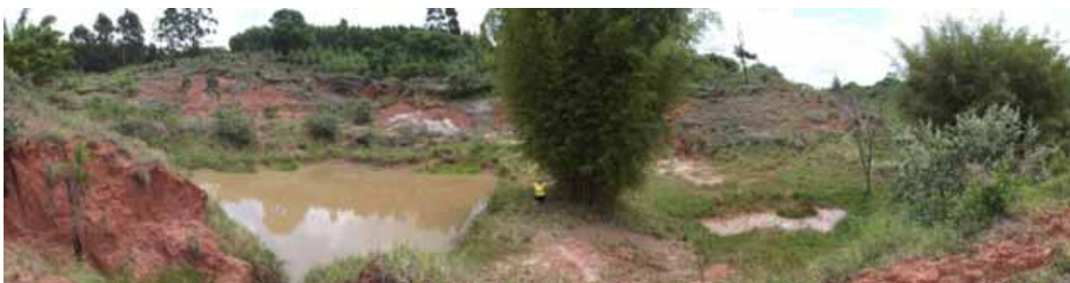
Foto 24. Erosão na cabeceira da drenagem 83g apresentando solo vermelho escuro no topo, e basaltos na base. Coordenadas: J29. 49°03'50"W x 22°29'42".
