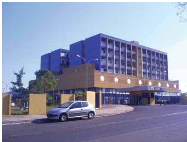
Vista do Hospital Estadual quando observado da parte da frente do terreno.
