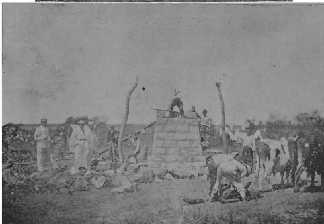
CONSTRUÇÃO DO MARCO DA FÓZ DO QUARAHYM
