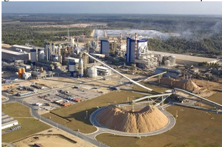
Figura 12 – Vista aérea da fábrica da Suzano em Imperatriz
