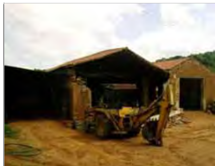
Foto 71: Serviços de terraplenagem no Bairro Rural da Roseira
