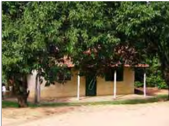
Foto 52: Antigo prédio escolar na Propriedade Mingoti
