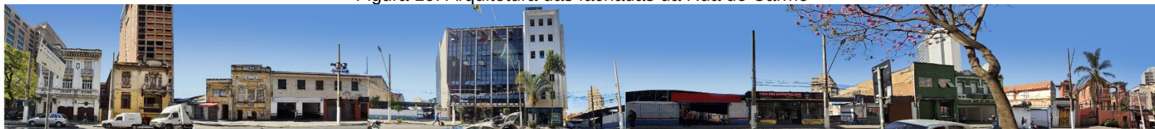
Figura 19: Arquitetura das fachadas da Rua do Carmo
