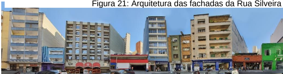
Figura 21: Arquitetura das fachadas da Rua Silveira Martins
