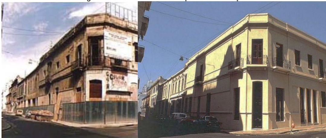
Figura 98: Fachada antes e após a reabilitação.
