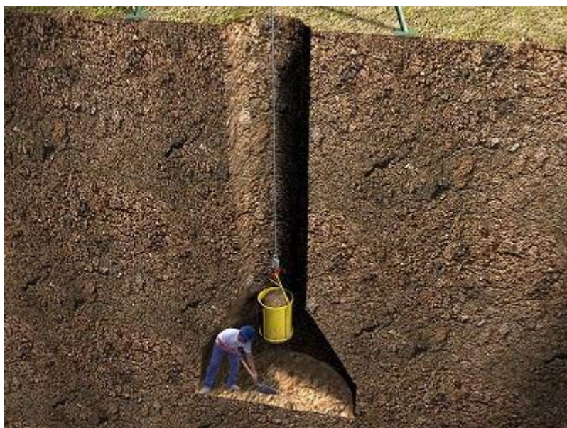
Figura 7 – Tubulão a céu aberto
