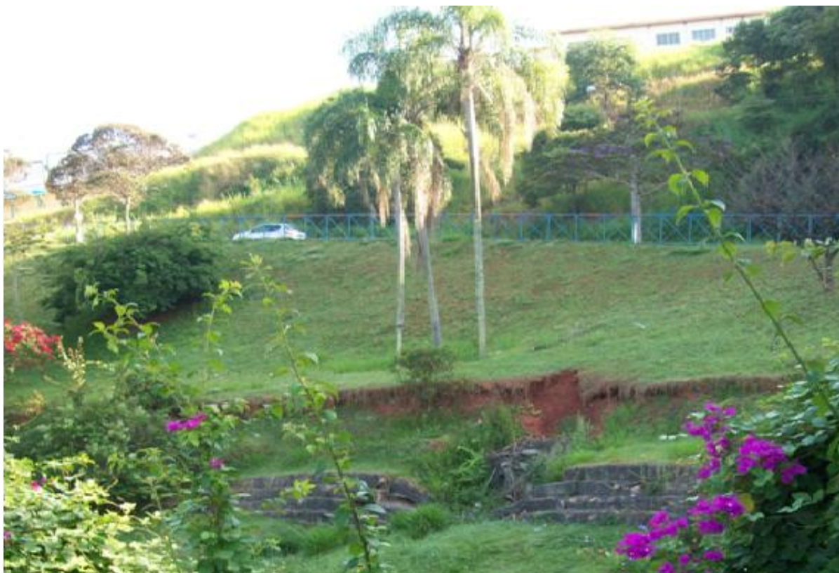
Figura 9 - A erosão na margem direita do Ribeirão do Chá no corrente ano (2012) denota a falibilidade da recuperação setorizada na área, neste trecho apenas a recuperação paisagística havia sido implementada. Fonte: SHECAIRA, 2012.
