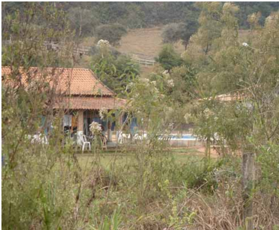
Figura 29. Área de lazer construída em áreas de preservação permanente (Rio Mandú).
