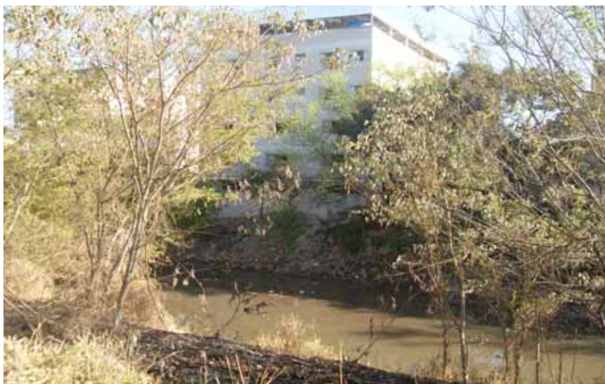
Figura 35 – Urbanização em áreas de preservação permanente (Pouso Alegre, MG).
