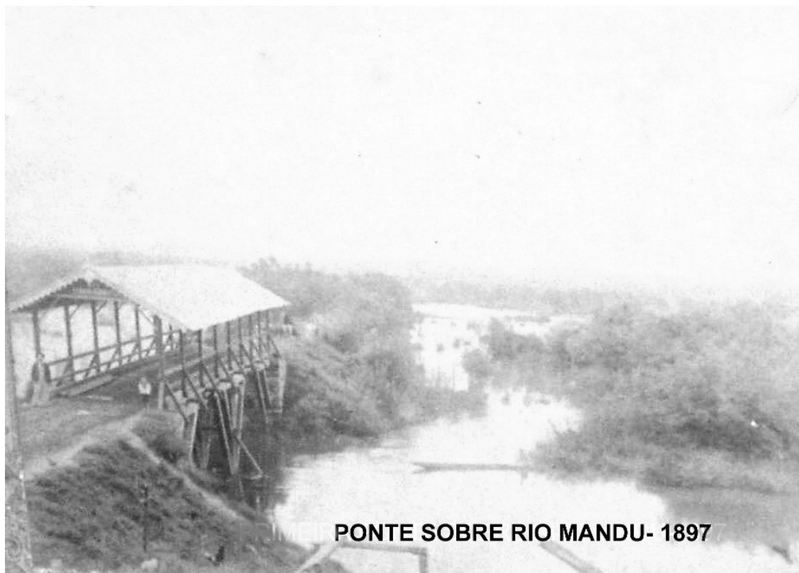
Figura 8. Ponte sobre o Rio Mandú em 1897.
