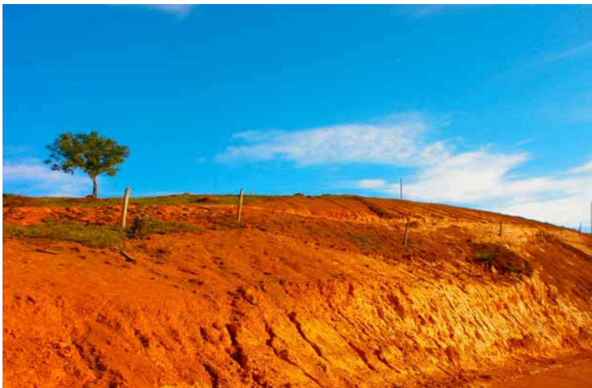
Figura 2. Erosão laminar e em sulco próximo ao Rio Mandú.
