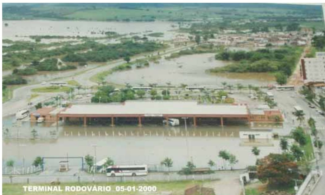
Figura 36 – Enchente no Terminal Rodoviário de Pouso Alegre (MG).
