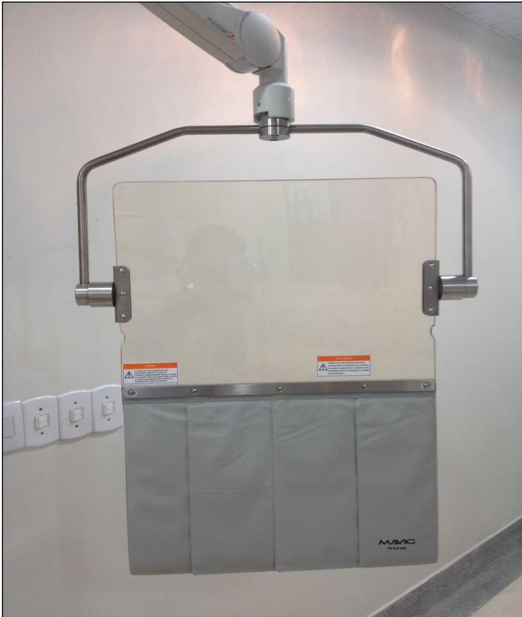
Figura 6. Cortina superior de radioproteção tipo anteparo suspenso
