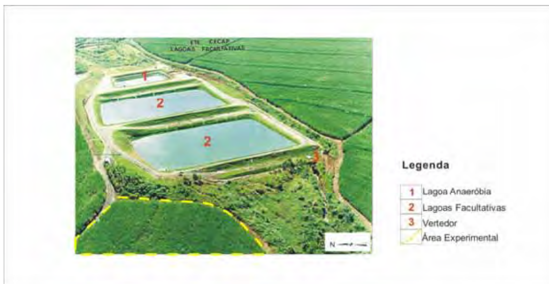
Figura 55 – Estação de Tratamento de Esgoto Cecap
