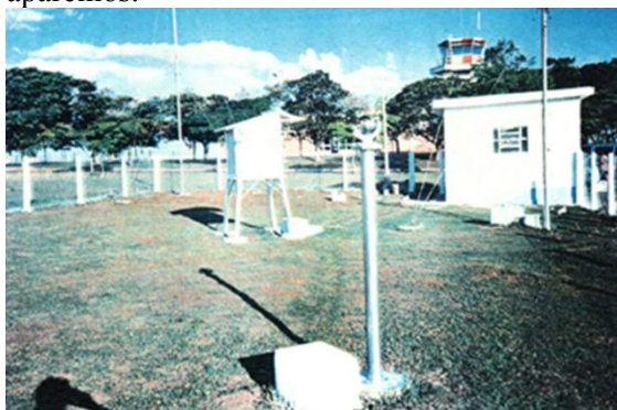
Foto 18. Vista da estação meteorológica de Franca após reforma e manutenção dos aparelhos.
