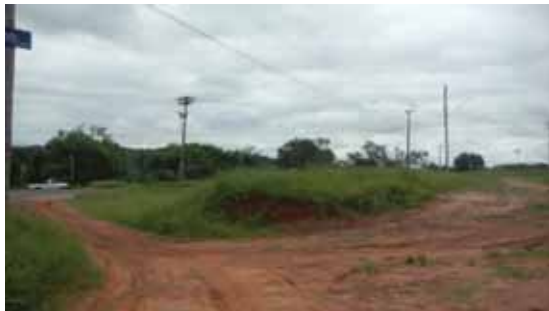
Foto 01: Vista da rua Rafael N.M. Oliares
