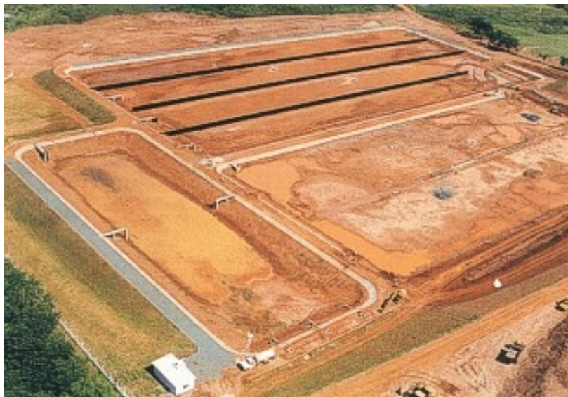
Figura 4.2 - ETE de Sta. Fé do Sul na fase de construção. Fonte: www. daee-sp gov.br
