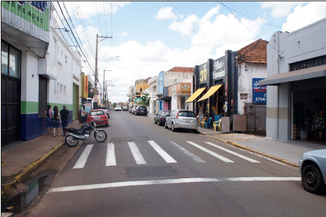
Figura 13: Rua Quintino Bocaiuva, zona periférica do centro principal (Janeiro/2024)
