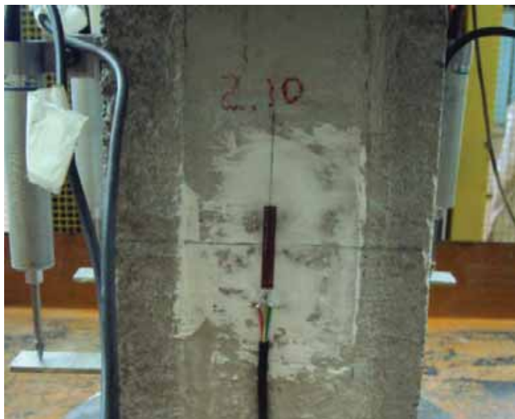
Figura 43 – Detalhe do extensômetro colado diretamente no graute
