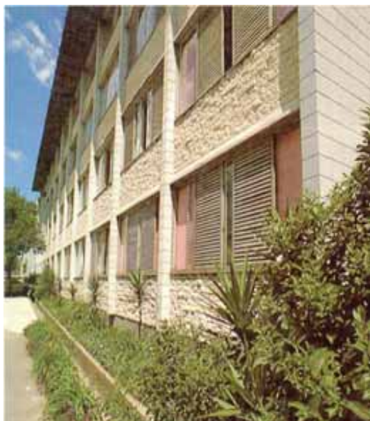
(a) Edificação do conjunto habitacional Central Park Lapa
