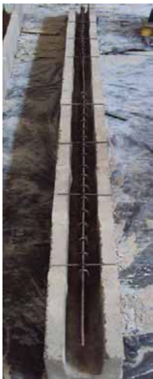
(a) Vigas canaletas
