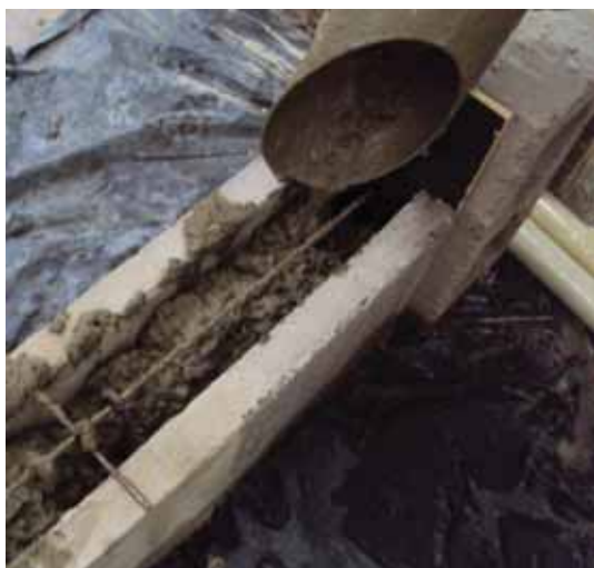
(b) Grauteamento das vigas
