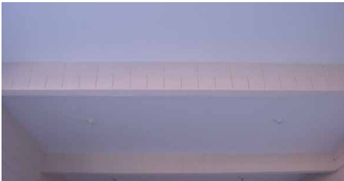
Figura 4 – Vigas de alvenaria estrutural utilizadas para apoiar a laje da edificação
