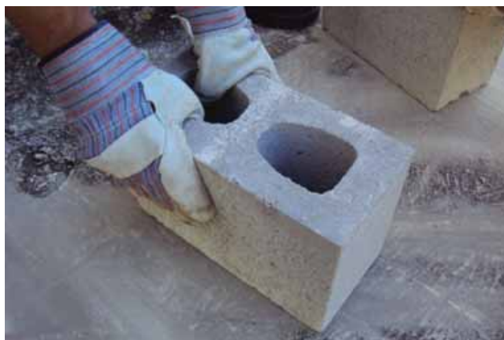
(a) Raspagem da superfície irregular dos blocos
