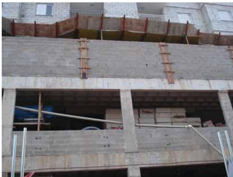
(b) Detalhe de pilotis em concreto armado
