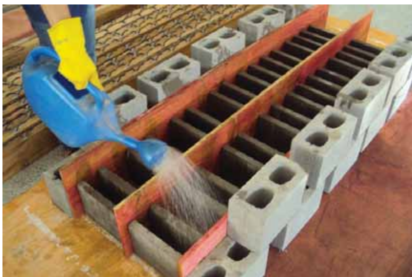
(a) Molhagem das canaletas e dos blocos
