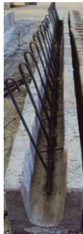
(b) Vigas de 2 e 3 fiadas
