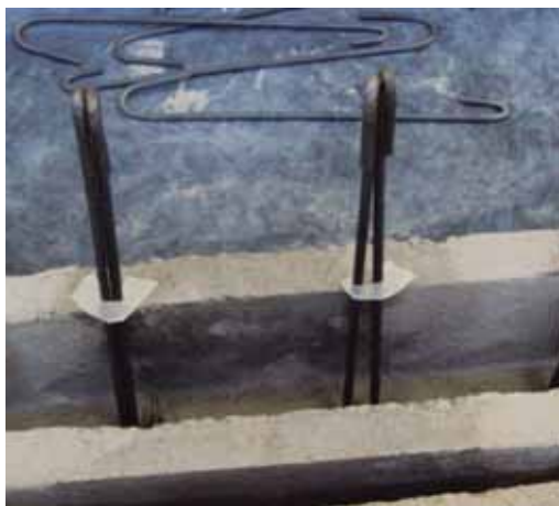
Figura 53 – Detalhe da fita adesiva utilizada para fixar o estribo na canaleta
