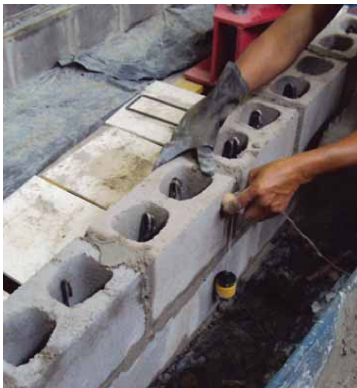
(a) Assentamento dos blocos vazados – vigas de 2 e 3 fiadas
