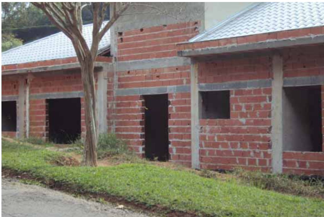
Figura 2 – Vergas feitas com canaletas de concreto
