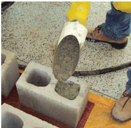
(a) Preenchimento dos vazios
