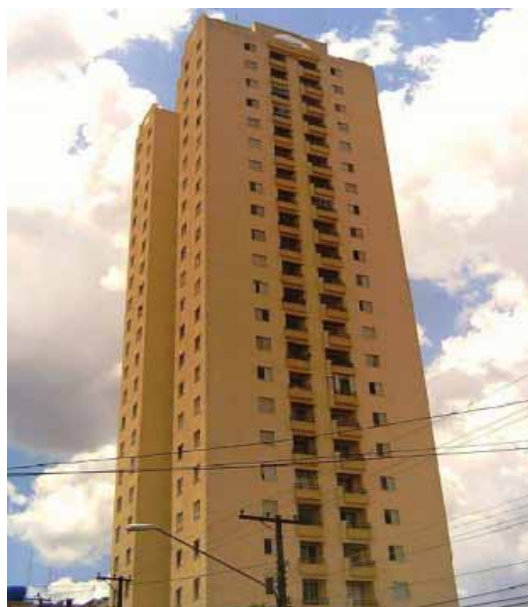
(b) Edificação residencial Solar dos Alcântara
