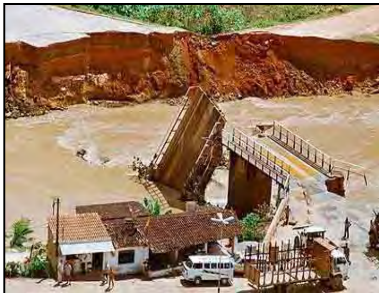
Figura 10: Ponte na cidade de Maraial (PE) cai devido às chuvas na região. Apresenta danos e perdas humanas significativos – 58 pessoas mortas e mais de 150 mil desabrigadas.
