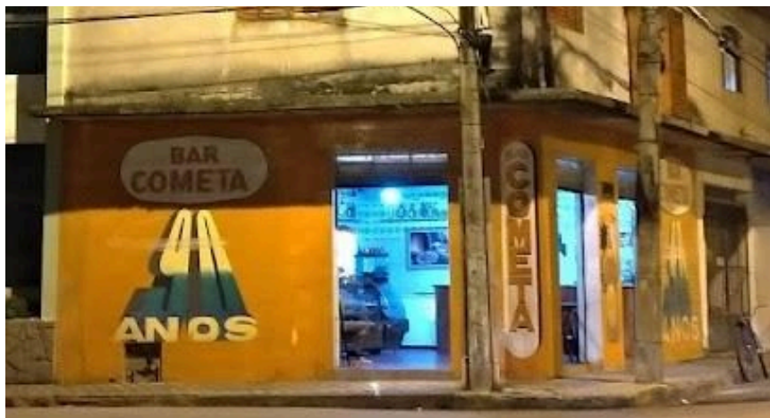
Figura 68: Fachada do Bar Cometa em Lorena-SP, década de 2010.
