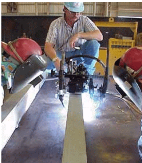
Figura 2.4 Exemplo de sistema de translado da tocha utilizado na soldagem GMAW. ( http://www.weldreality.com/flux-cored-bug-o-2.gif , julho, 2007).
