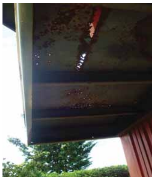
Figura 36 – Detalhe da foto anterior, parte inferior da porta (à esq.) e assoalho do primeiro patamar do mirante, extremamente enferrujado e se desfazendo (à dir.). Fonte: Foto tirada pela autora, 2011.
