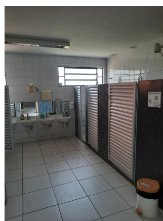
Figura 37 - Interior do banheiro
